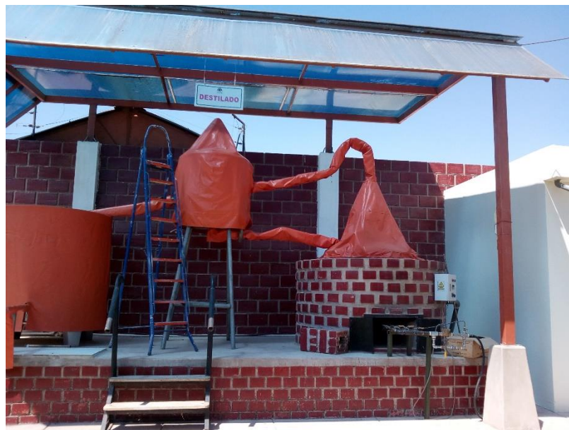
Verificación de ambientes: Bodega Marquez Cariñoso.
