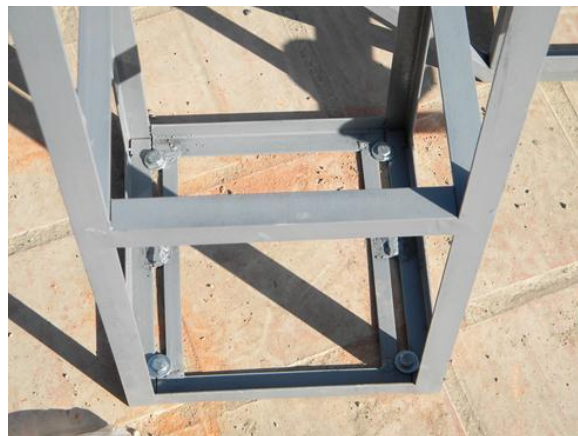
Figura 32. Anclaje de columnas de soporte al techo del CERT.
