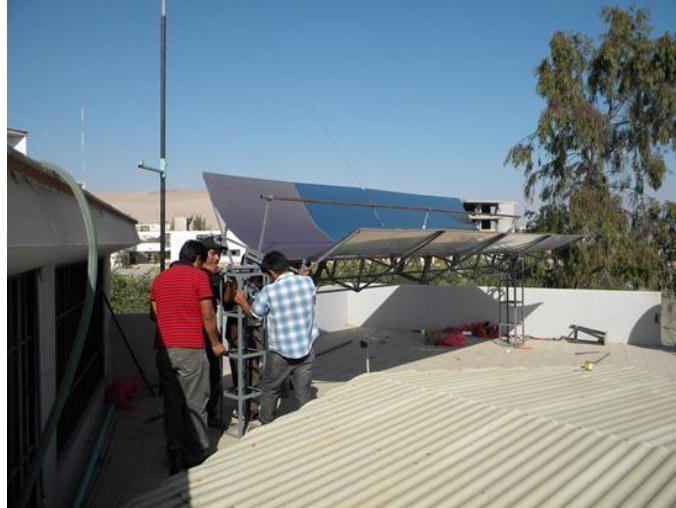
Figura 33. Montaje de la estructura parabólica a las columnas de soporte.
