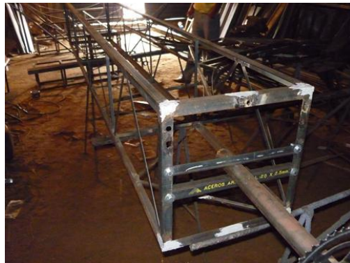
Figura 25. Construcción de la viga principal del CCP
