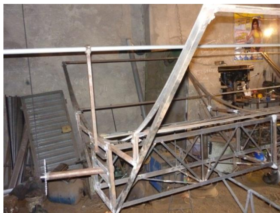
Figura 26. Construcción de los arcos parabólicos
