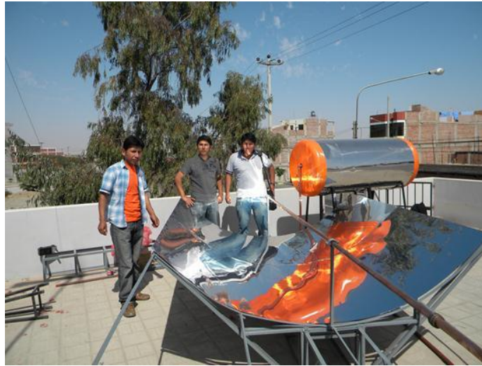
Figura 31. Colocación de superficie reflectora
