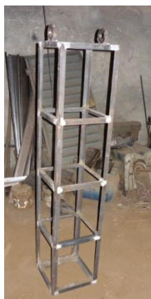
Figura 24. Construcción del soporte metálico del concentrador
