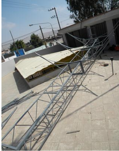
Figura 29. Colocado de los arcos parabólicos
