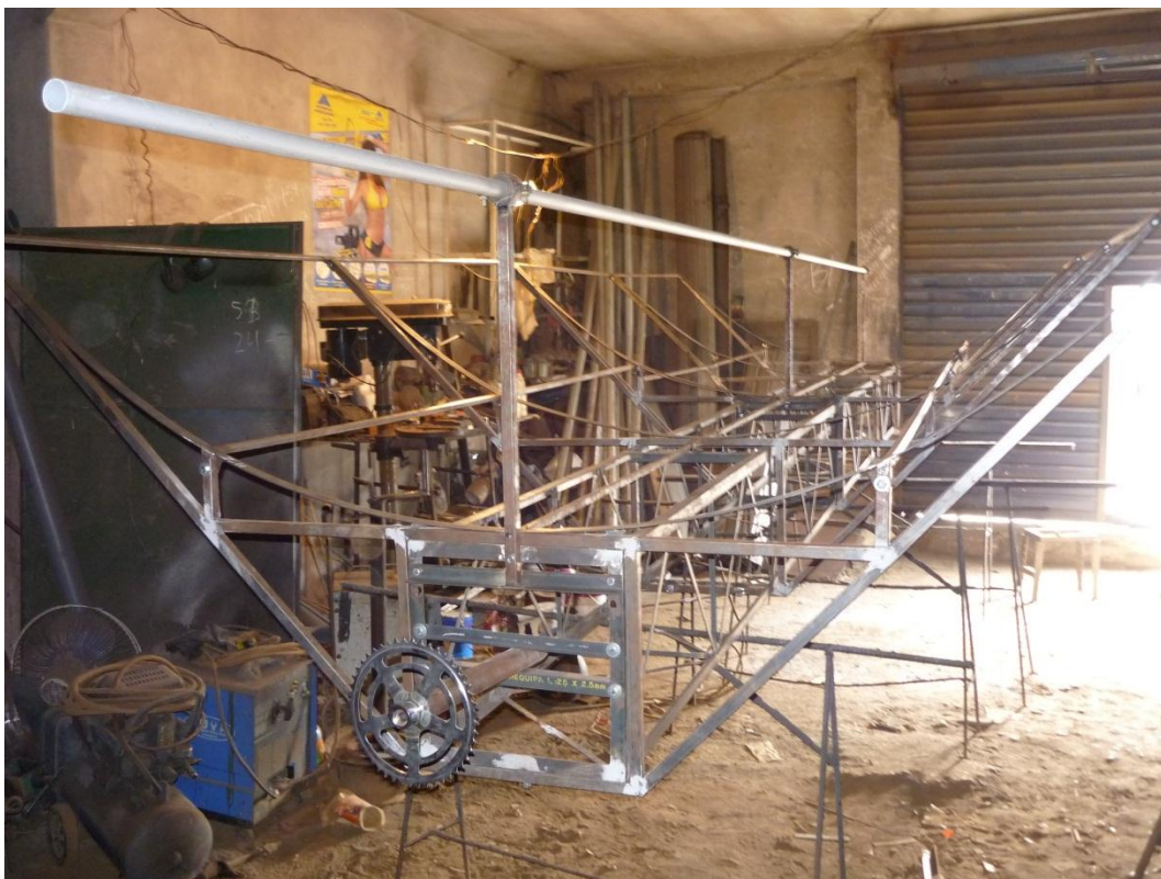
Figura 27. Construcción del soporte para el tubo absorbente y soportes para la superficie reflector
