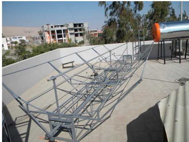
Figura 30. Colocado de soporte para tubo absorbente y superficie reflectora
