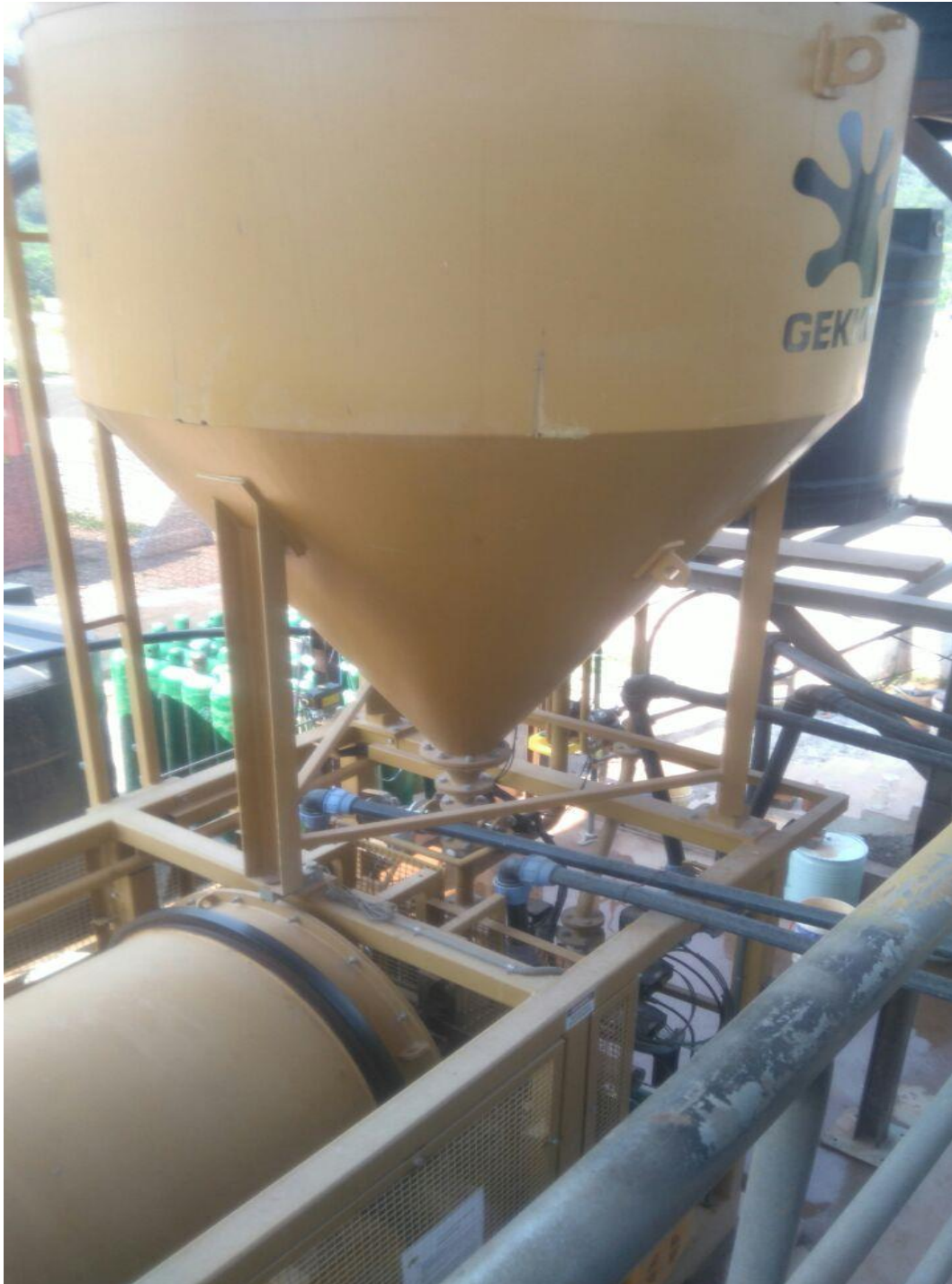
Figura 27. Vista frontal de la tolva de alimentación al ingreso del equipo Gekko. Fuente: Elaboración propia.
