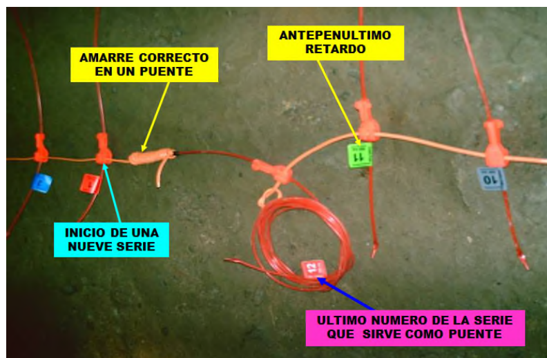
Figura N° 16: Aplicación de puentes
