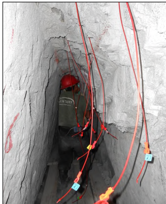
Figura 31: Carguío, usando fanel y emulnor 1000 en el tajeo 7690
