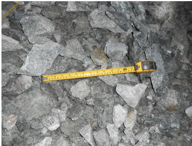
Figura N° 32: Fotografía después de la voladura
