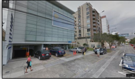
Imagen N° 26 Vista exterior – Hacia la Av. Principal Chacarilla medicina física y rehabilitación
