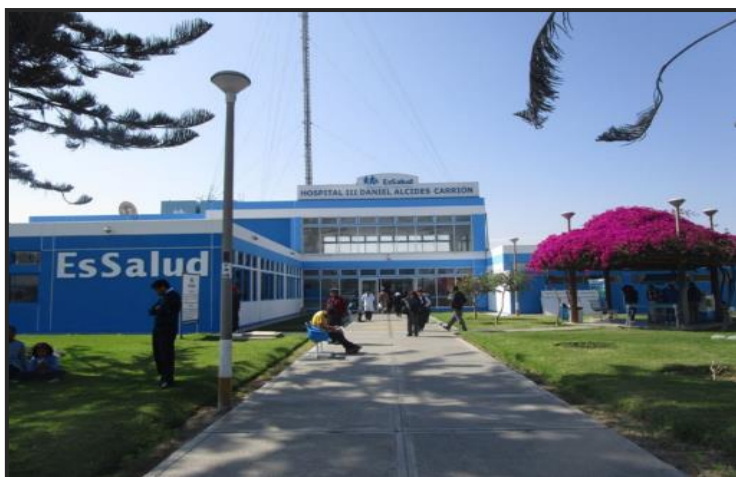
Imagen N° 69 Fachada Principal de Essalud
