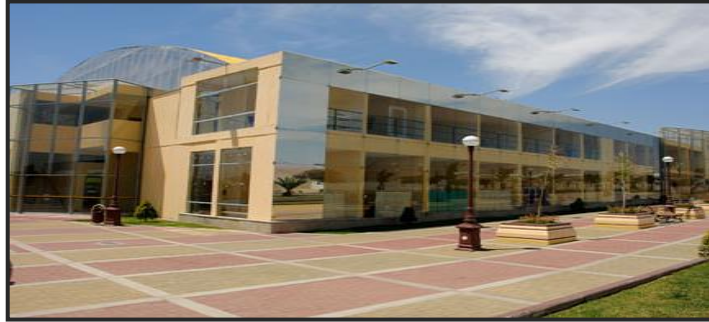
Imagen N° 71 Fachada de SISOL "Hospital de la Solidaridad"
