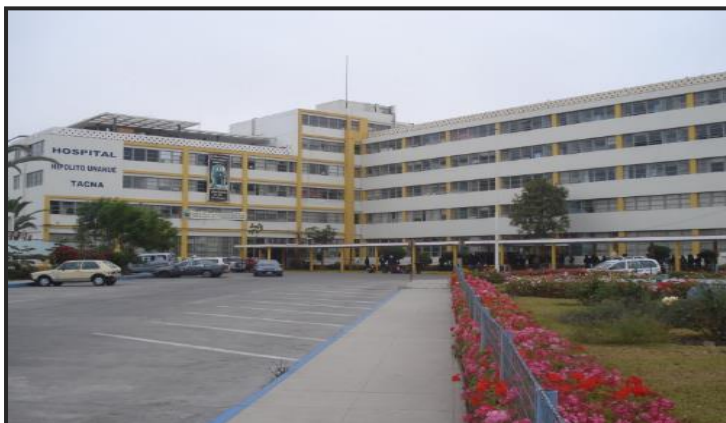
Imagen N° 72 Fachada principal del Hospital Hipólito Unanue
