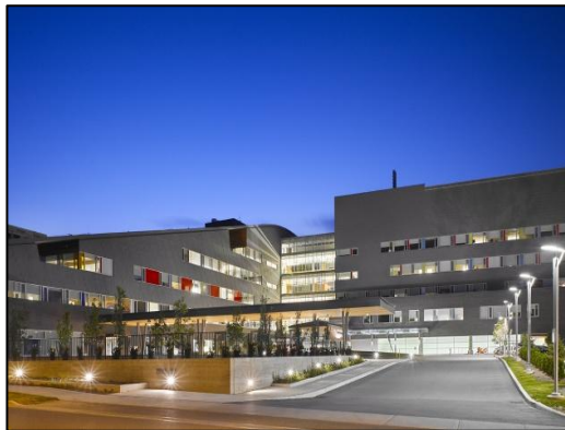
Imagen N° 38 Vista exterior del Holland Bloorview Kids Rehabilitation Hospital.
