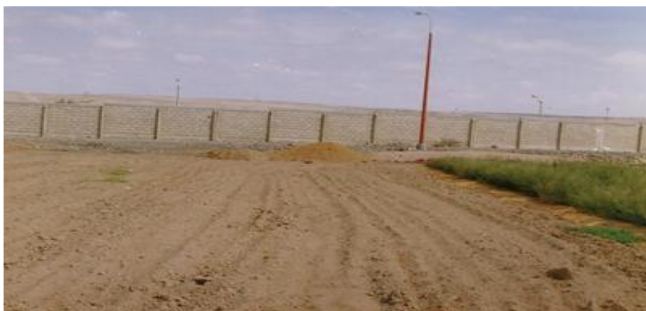
Figura 1. Nivelación del suelo
