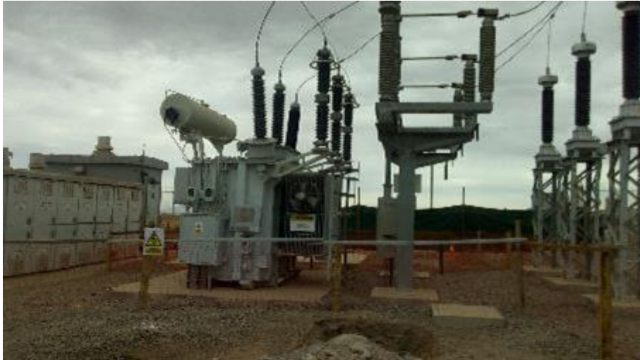
Transformador 30 MVA
