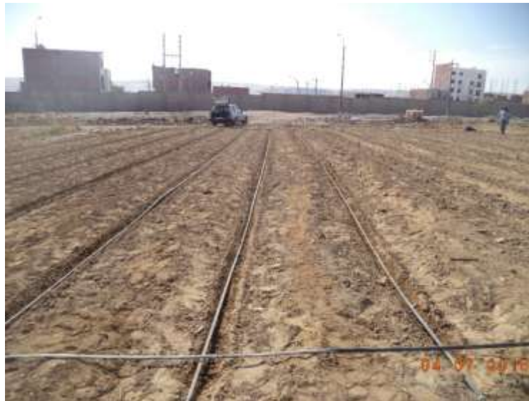
Fotografía 01: Preparación del terreno
