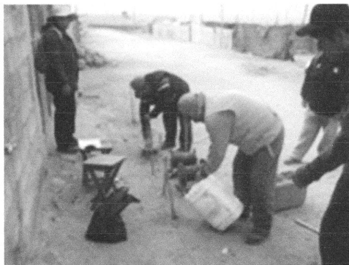
Foto N° 04.- Vista del Sondaje eléctrico vertical N° 02 efectuado sobre material de relleno.
