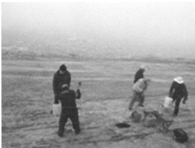
Foto N° 01.- Sondaje eléctrico vertical (SEV) N° 01, efectuado al borde del Cerro Intiorko sobre depósitos eólicos y depósitos redepositados producidos por la meteorización de la zona.
