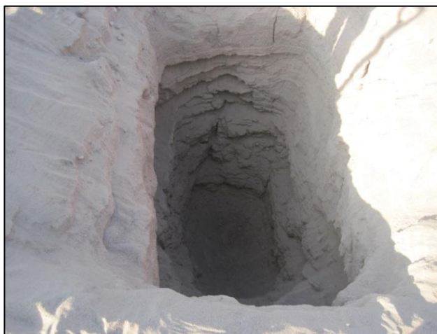
Figura 10. Excavación a 3 m de profundidad de una de las 12 calicatas ejecutadas en la zona del estudio geotécnico
