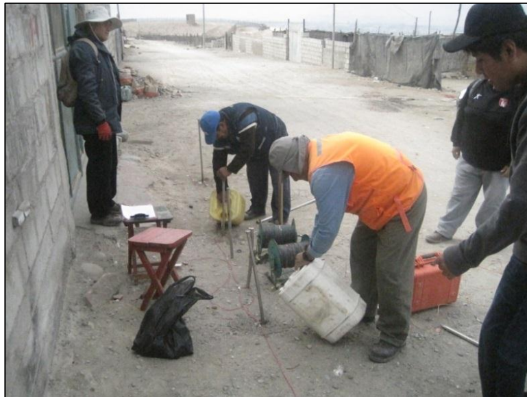
Figura 09. Ejecución del sondeo eléctrico vertical en una vía de circulación en la zona de estudio
