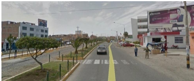
Figura 65 Vista de la Av. Municipal
