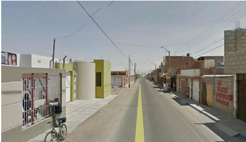
FIGURA 27. Vista frontal de la tecnología constructiva del sector.
