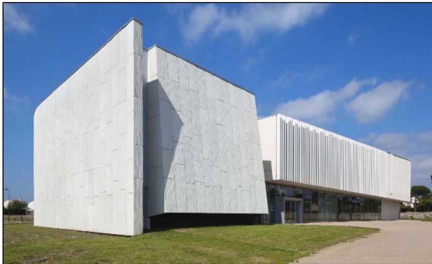
Imagen 17 Vista de fachada principal
