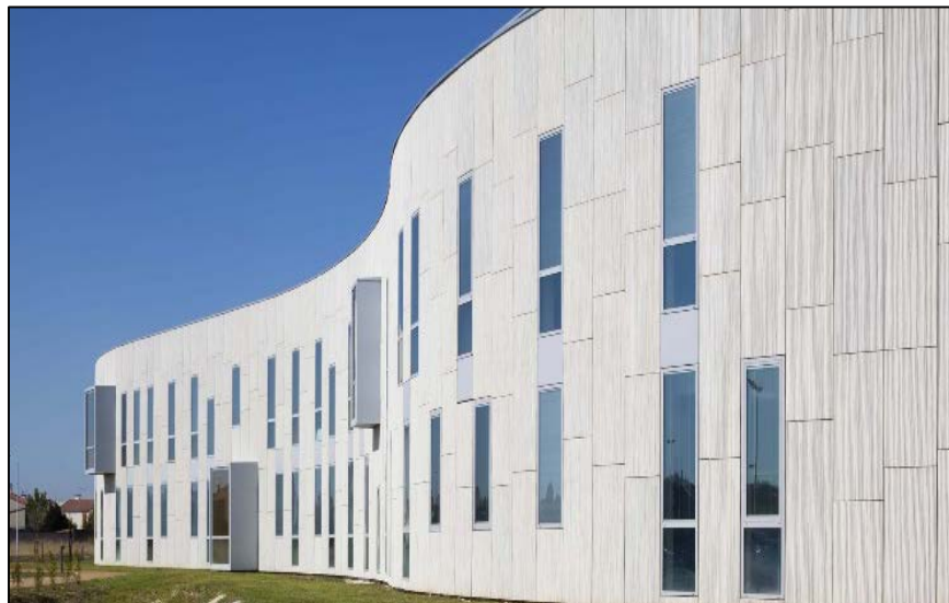
Imagen 15 Vista de fachada curvilínea
