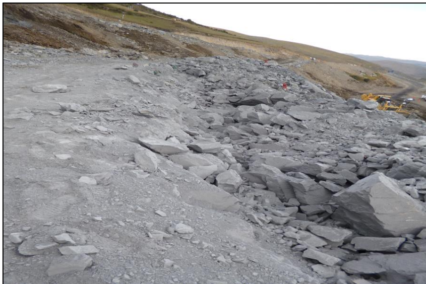
Figura 17. Imagen de voladura con factor 0,30 \text{ kg / m}^3
