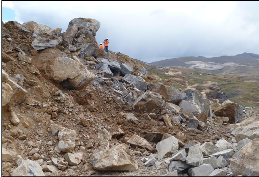
Figura 16. Imagen de voladura con factor 0,22 \text{ kg / m}^3
