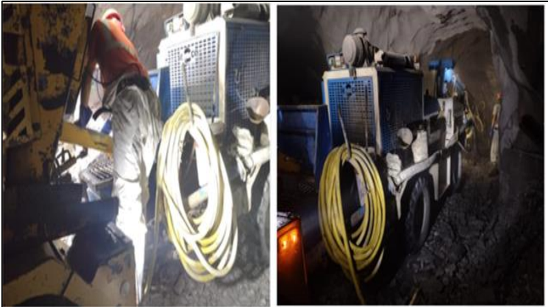
Figura: 27. Robot alpha 20 lanzando shotcrete en labor Fuente: Elaboración propia.
