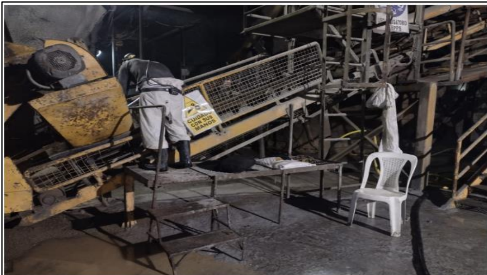
Figura 23. Banda transportadora de agregado Fuente: Elaboración propia.
