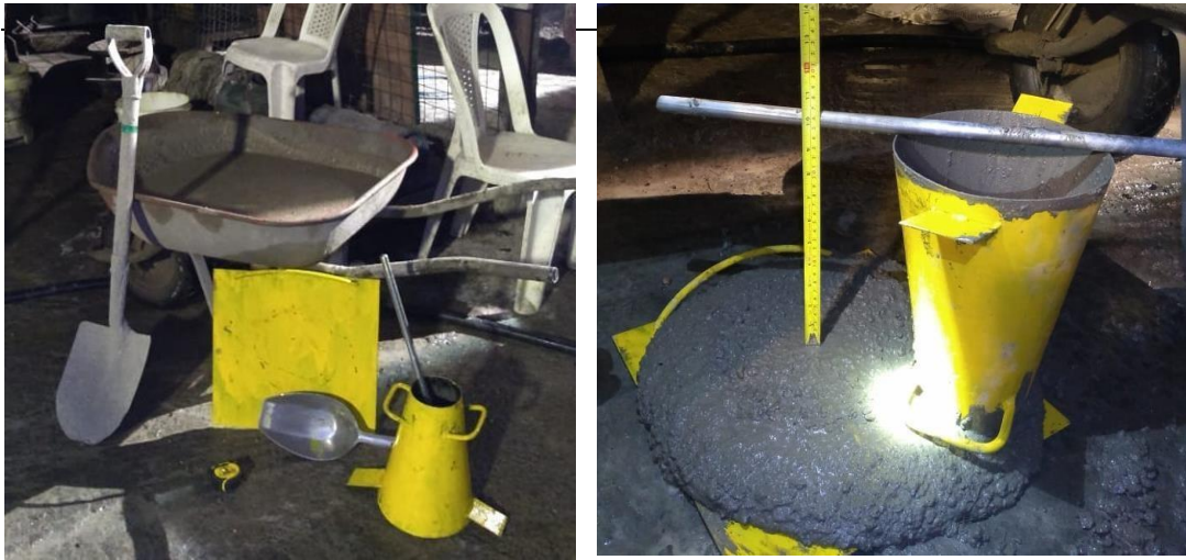
Figura 43. Ensayo de slump en planta Shotcrete Fuente: Elaboración propia.
