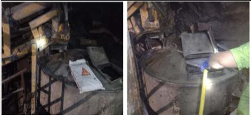
Figura 24. Mezclador tipo planetario abastecido de fibras metálicas Fuente: Elaboración propia.
