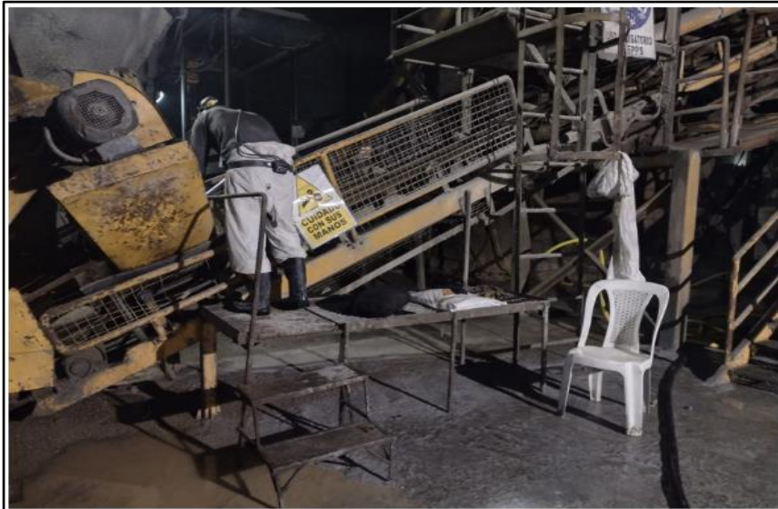
Figura 15. Banda transportadora Fuente: Elaboración propia – Interior mina nivel 14.
