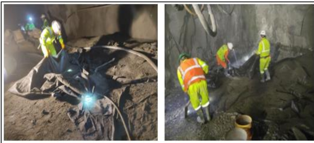
Figura 60. Colocación de mantas en labor para recepción del rebote.
