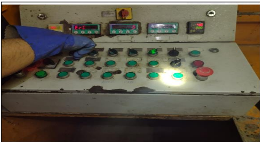
Figura 25. Control de dosificación de concreto Fuente: Elaboración propia.
