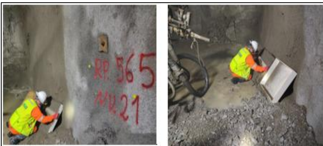
Figura 58. Paneles prismáticos colocados en la labor a lanzar Fuente: Elaboración propia.
