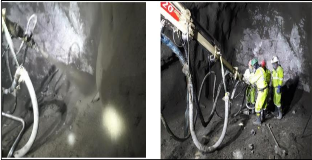
Figura 49. Colocación de shotcrete a los paneles Fuente: Elaboración propia.
