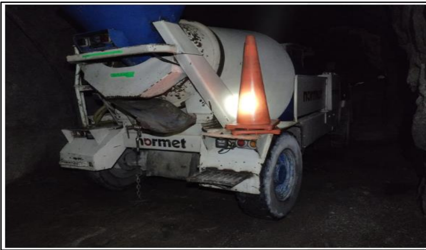
Figura 26. Equipo tornado recibiendo mezcla de shotcrete Fuente: Elaboración propia.
