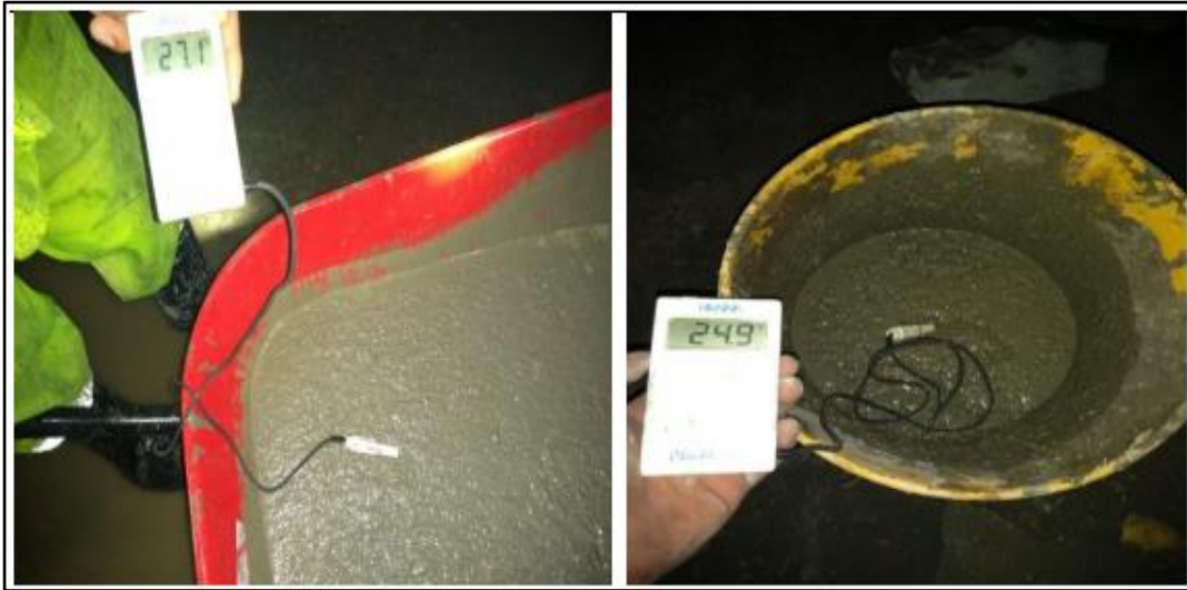
Figura 45. Control de temperatura de shotcrete Fuente: Elaboración propia.
