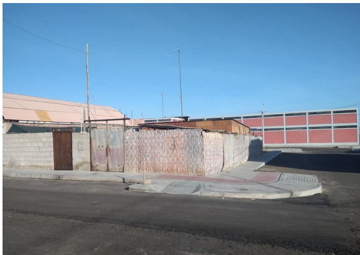
Figura 58 Edificación de material precario
