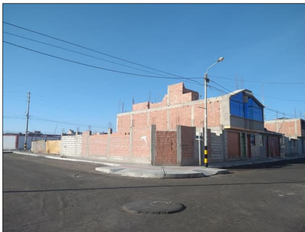
Edificación de albañilería confinada
