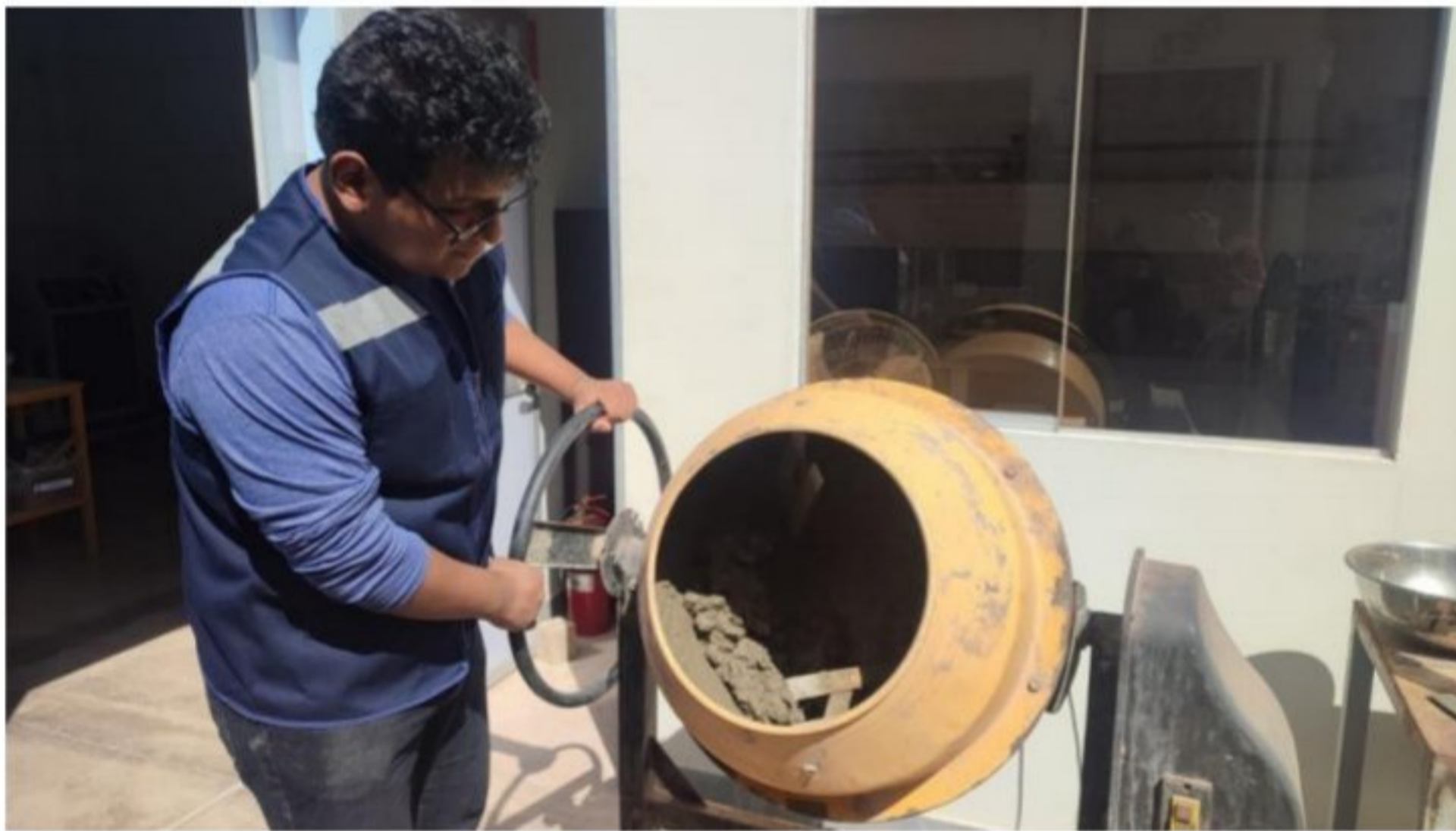
Figura 11. Elaboración de mezcla de concreto autocompactante
