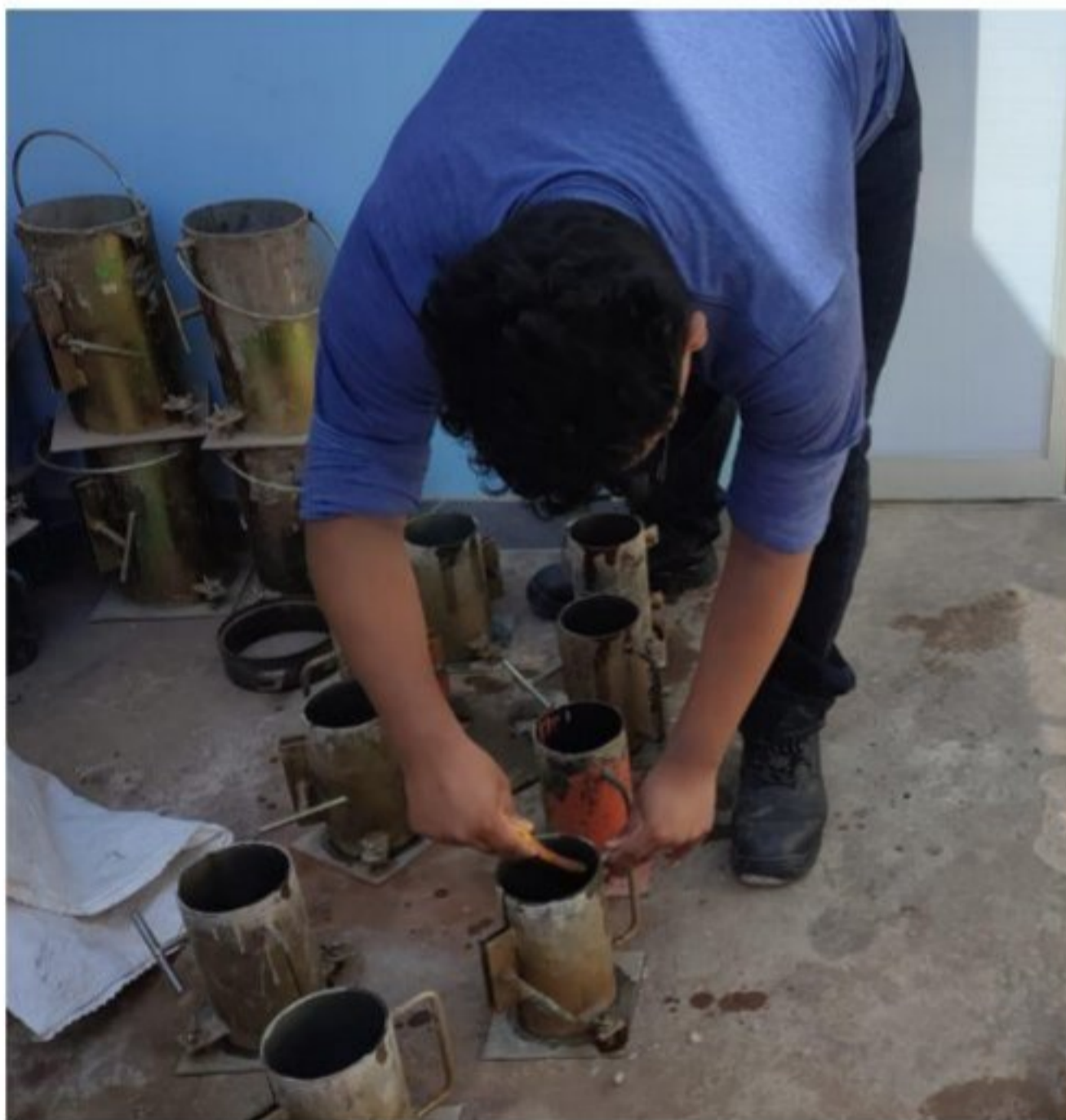
Figura 07. Colocación de desmoldantes a los moldes de testigos de concreto
