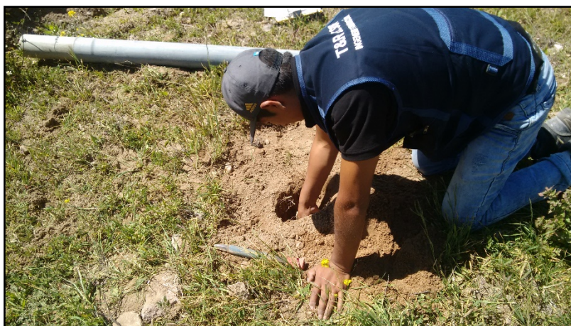
Figura 45: Excavación del hoyo para realizar la prueba de tasa de infiltración.
