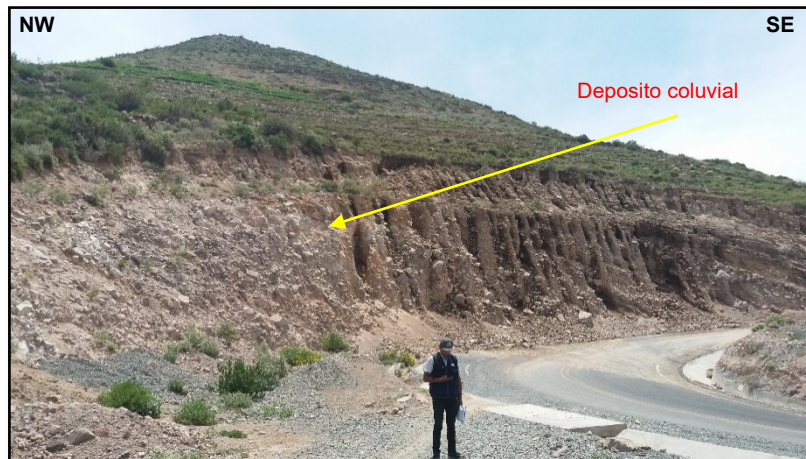
Figura 24: Deposito coluviodeluvial, donde se aprecia los fragmentos de roca volcánica y matriz de arena limosa origen tobasea.
