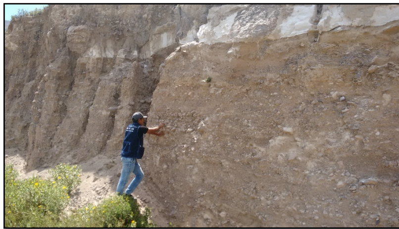
Figura 30: Vista del perfil estratigráfico de T-05 en deslizamiento de Matarani.
