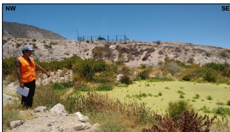
Figura 54: Depósito de aguas servida, producto de mal uso de planta de tratamiento.
