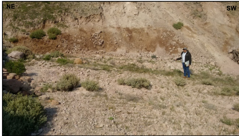
Figura 72: Se muestra humedad en la parte baja del deslizamiento de Matarani, proveniente de la infiltración por riego en las áreas de cultivo.
