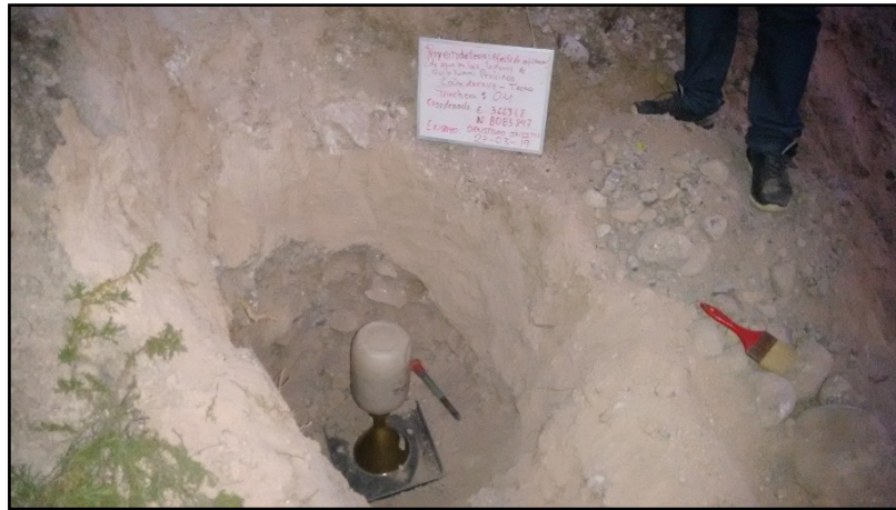
Figura 31: Ensayo densidad in situ por el método de cono.
