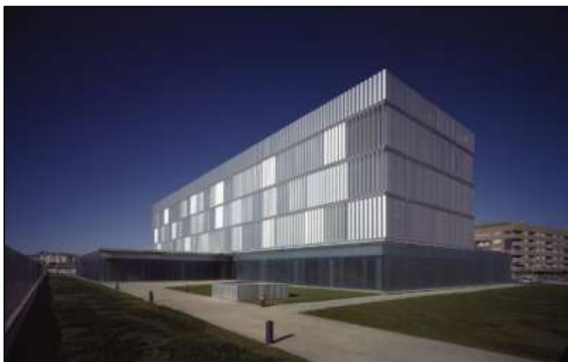
Figura 10. Vista de la fachada principal
