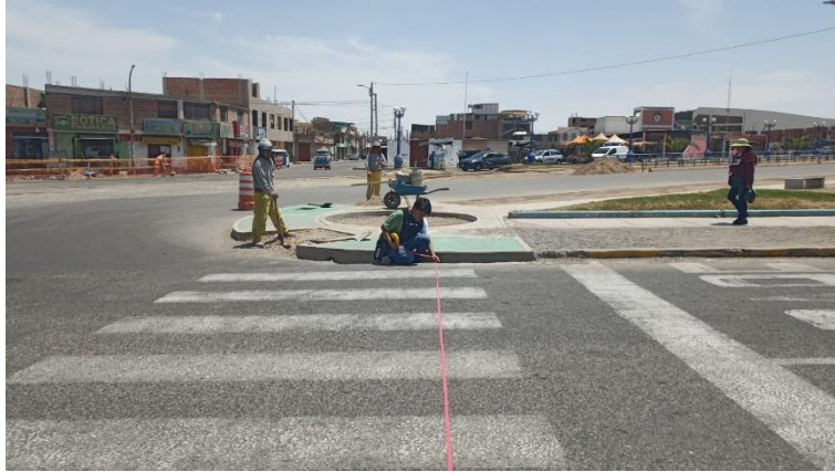
Medición del ancho de carriles en la Avenida Humboldt (Estación 1)
