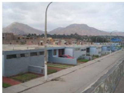
AVENIDA SIMÓN BOLÍVAR EDIFICACIONES DE 1 A 2 NIVELES DE ALTURA.
