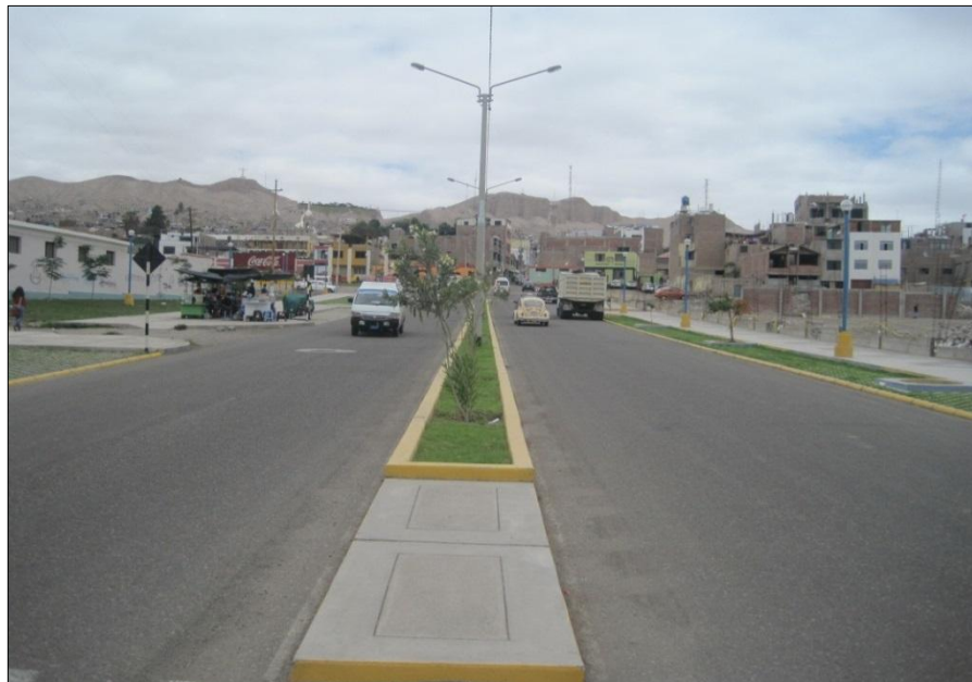
Figura 54. Vía principal calle Ancash
