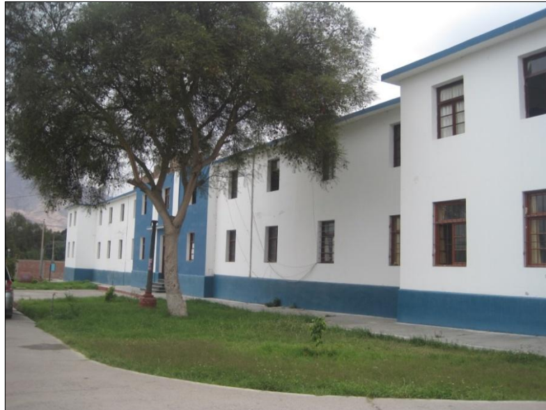
Figura 18. Vista frontal del módulo administrativo Fuente: Trabajo de campo
