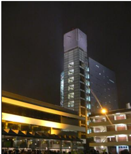
Vista de Edificio Administrativo
