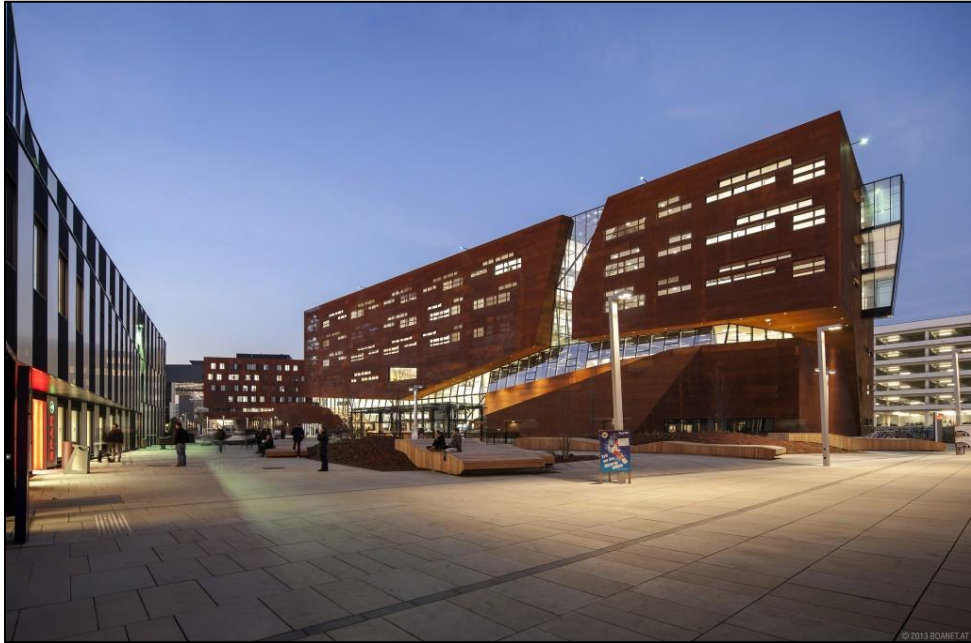
Vista exterior del edificio departamental
