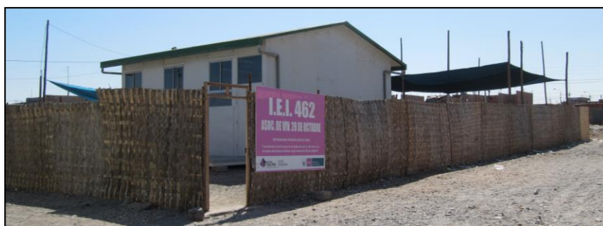
Cerco perimétrico provisional
