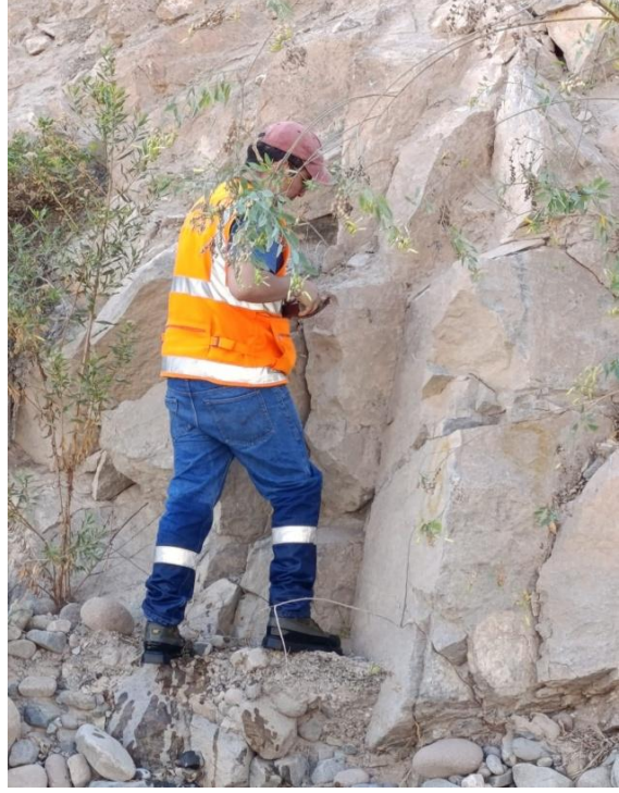
Foto N°1.- Levantamiento de discontinuidades y puntos de control
