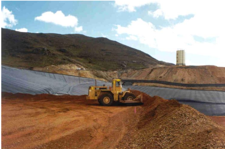
Figura 11. Tractor de ruedas conformando la pila. Fuente: Archivos de mina Pucamarca-MINSUR.
