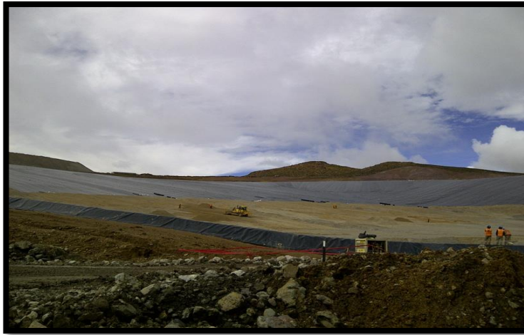
Figura 8. Preparación del pad con la geomembrana. Fuente: Archivos de mina Pucamarca-MINSUR.
