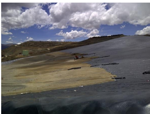
Figura 17. Aspectos constructivos del método VLP en Pucamarca-Minsur. Fuente: Archivo de mina Pucamarca, 2016.
