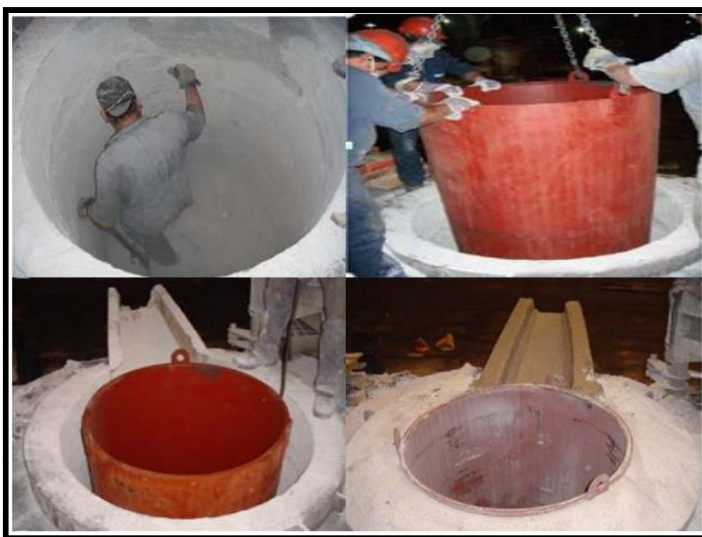
Figura 3. Fabricación del crisol del horno
