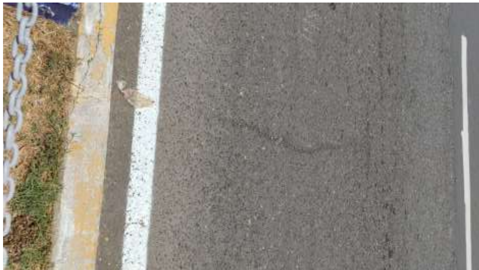
Fisura Transversal
