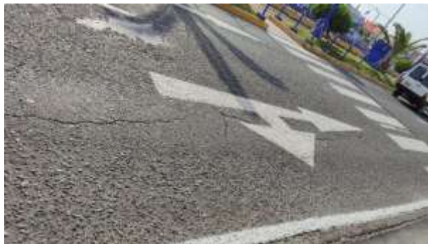
Fisura Longitudinal
