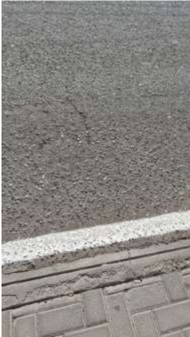
Fisura Transversal
