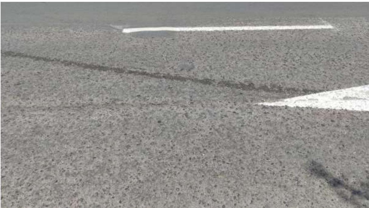
Fisura Longitudinal
