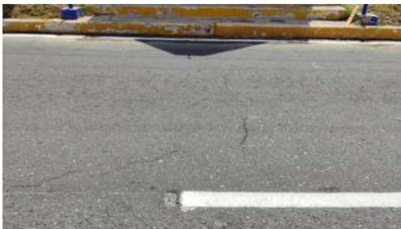
Fisura Transversal
