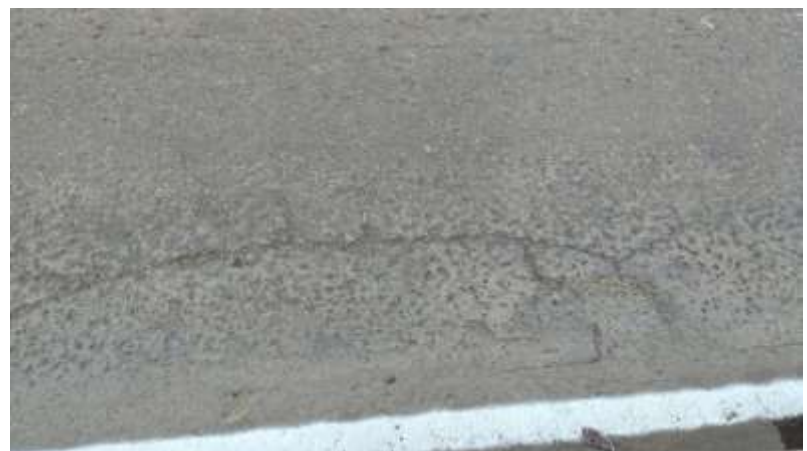
Grieta Parabolica
