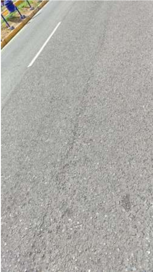
Fisura Longitudinal
