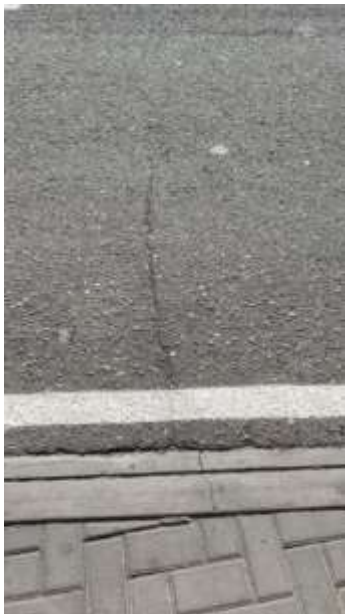
Fisura Transversal
