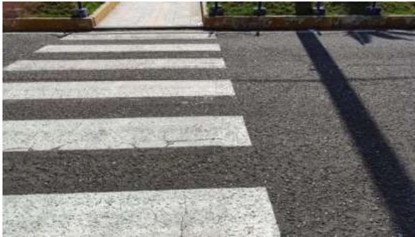
Fisura Longitudinal
