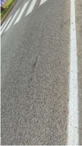
Fisura Longitudinal
