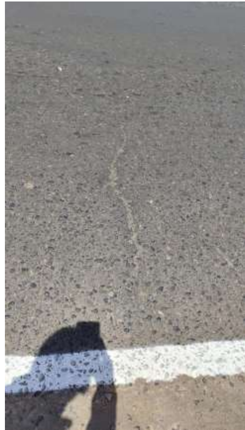
Fisura Transversal
