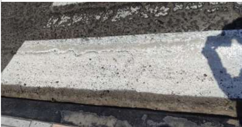
Fisura Longitudinal
