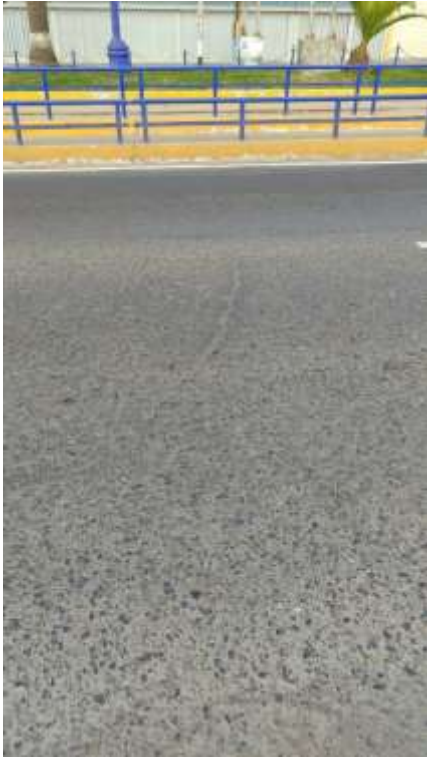
Fisura Transversal
