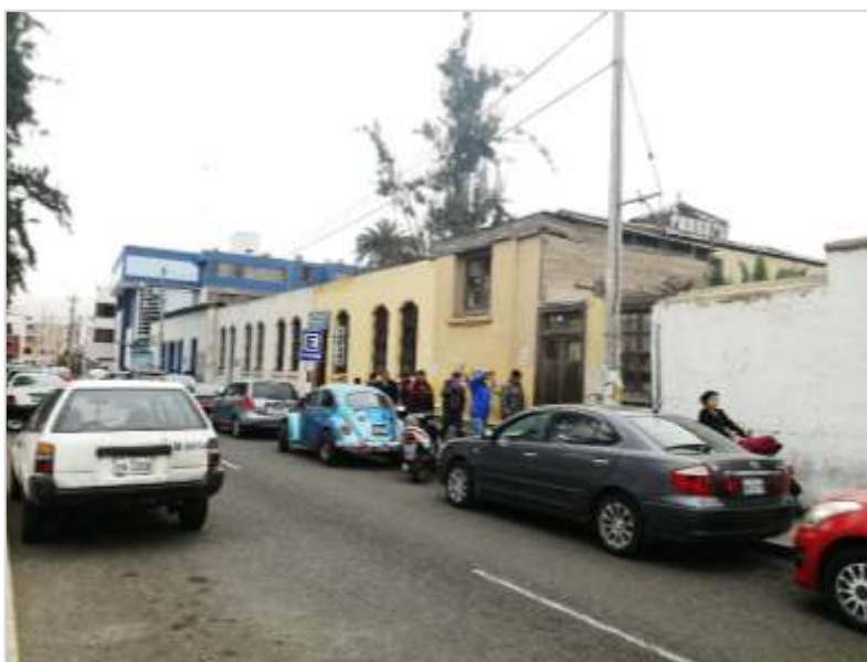
Figura 16. Estado actual de bloque B-vista frontal Fuente: Elaboración propia
