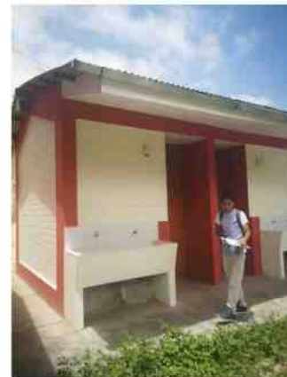
Imagen: Agua Potable Fuente: Propia
