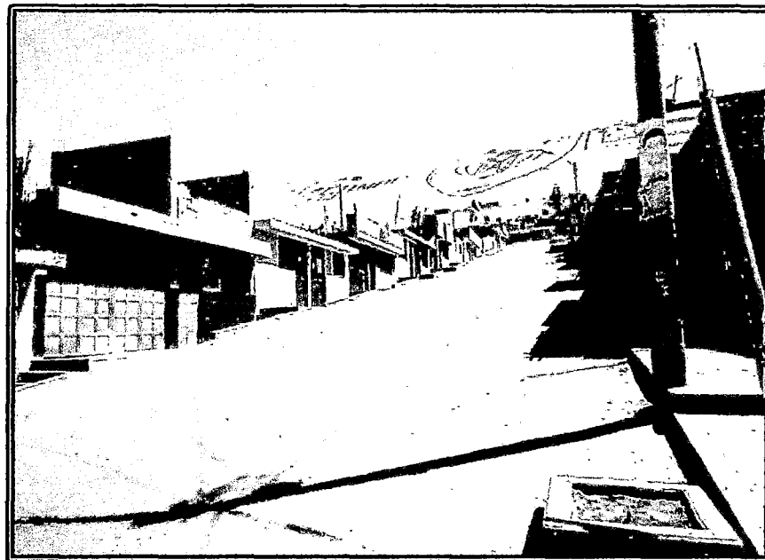
Fotografía 10: Viviendas típicas de albañilería de un piso, con vía asfaltada, ubicadas en las laderas del cerro Intiorko del distrito de Ciudad Nueva - Tacna,
