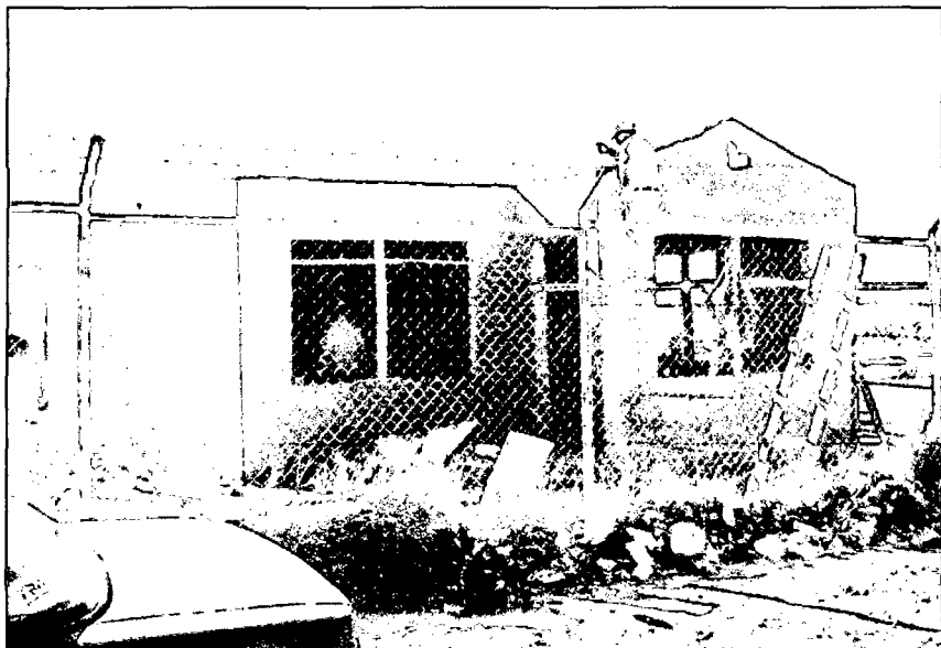
Foto 9, 10 = Tarrajeo en muros interiores y exteriores en los que se utilizó unidades de concreto celular
