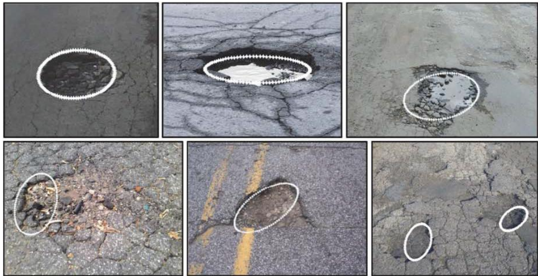
Figura 24. Detección de huecos a partir de algoritmos de detección de borde y Umbralización Fuente: (Herra, 2018)
