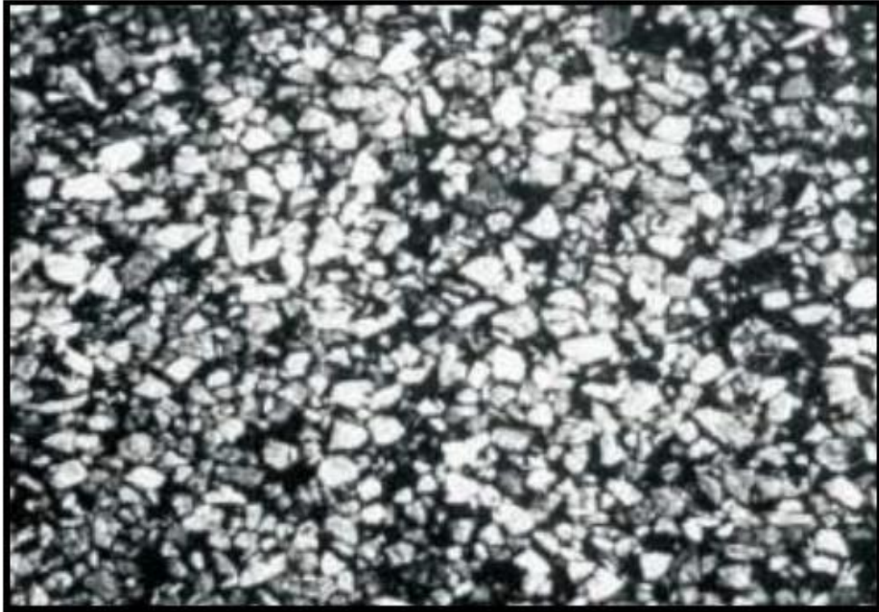
Figura 12. Pulimiento de agregados sin clasificación de severidad definido. Fuente: (Vásquez, 2002)
