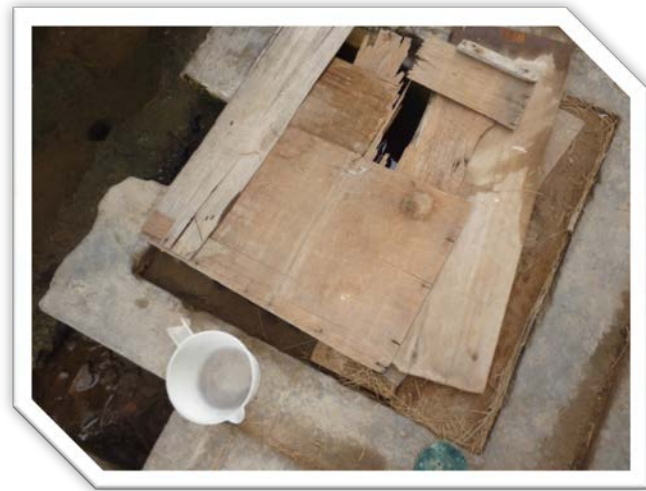
Foto 05: Pozo con cubierta inadecuada.
