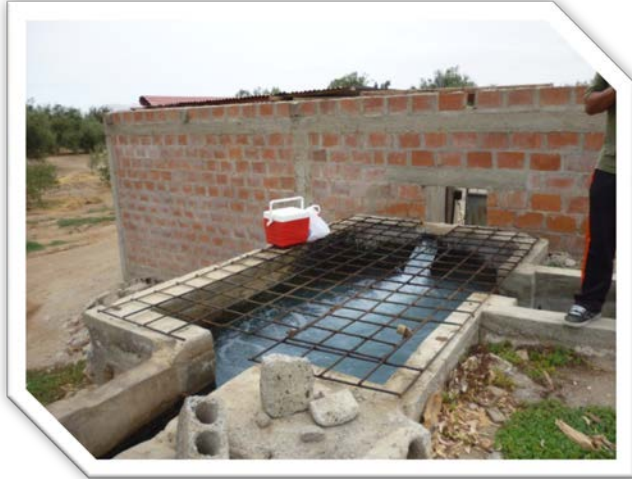
Foto 05: Pozo con cubierta inadecuada.
