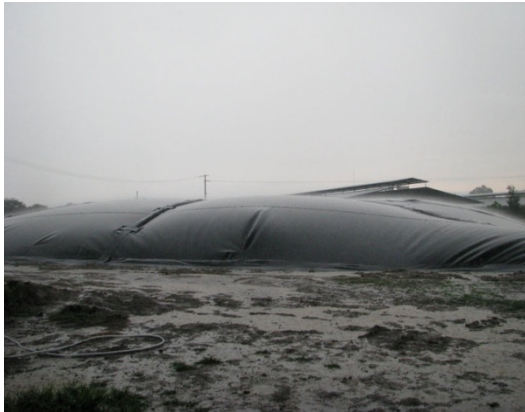
Biodigestor instalado en la granja de La Joya – Puebla, México (Fuente: Proyecto MOPESA).
