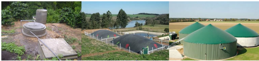
Figura 3: Modelos de biodigestores. De izquierda a derecha se tiene el modelo chino, modelo manga de geomembrana y una planta de biometano. Fuente: Servicios Manufactureros, (consultado en Enero 2012).
