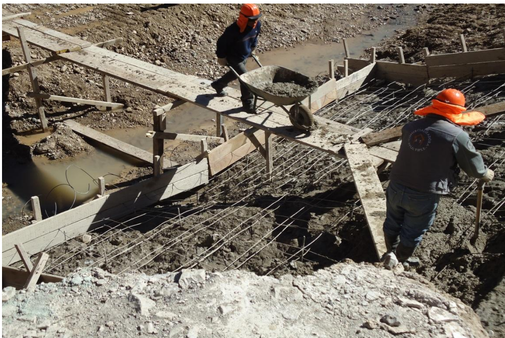
FIGURA N° 38 Vaciado del grout cap
