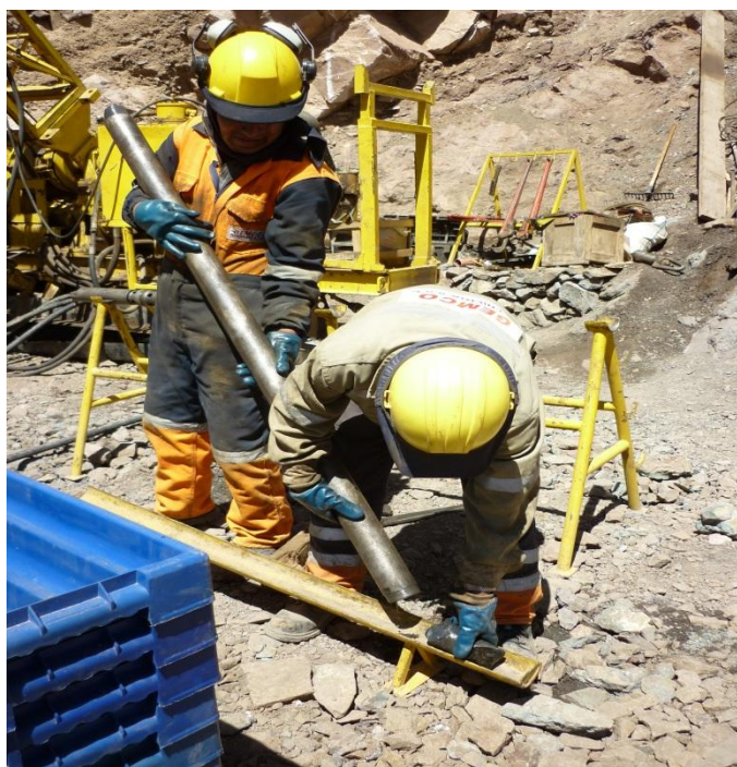
FIGURA N° 31 Extracción de la muestra en el sondeo PE-6 (Prog. 0+075)
