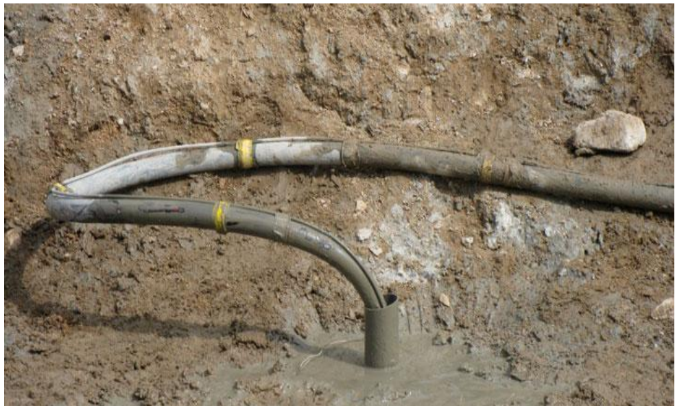
FIGURA N° 23 Mangueras para inyección de lechada de cemento
