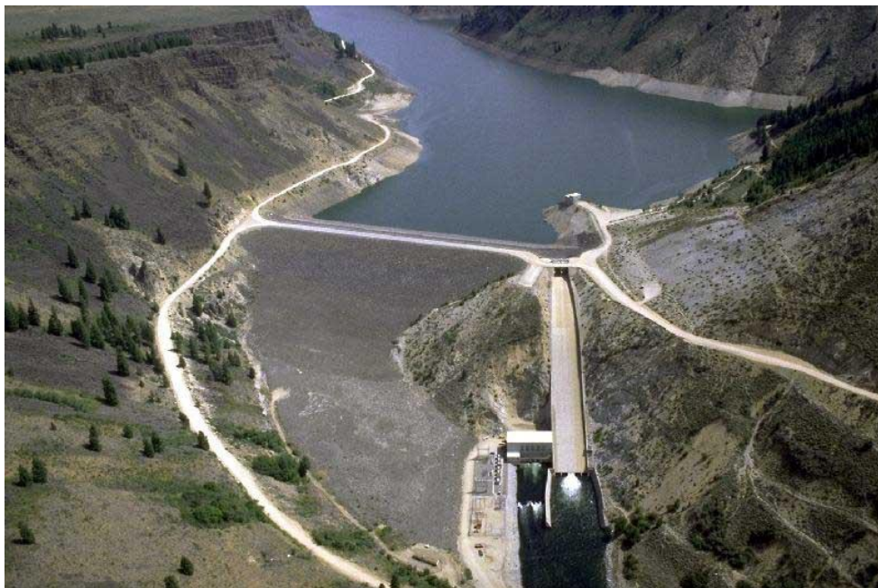
FIGURA N° 05 Presa con canal de demasías
