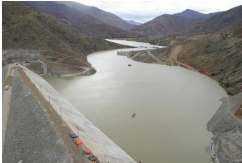
FIGURA N° 01 Presa de embalse
