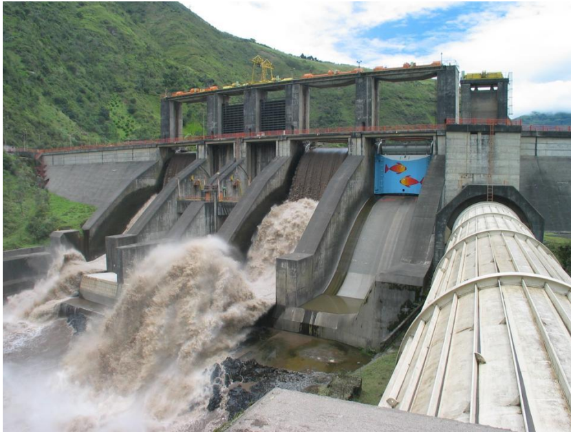
FIGURA N° 02 Presa de derivación
