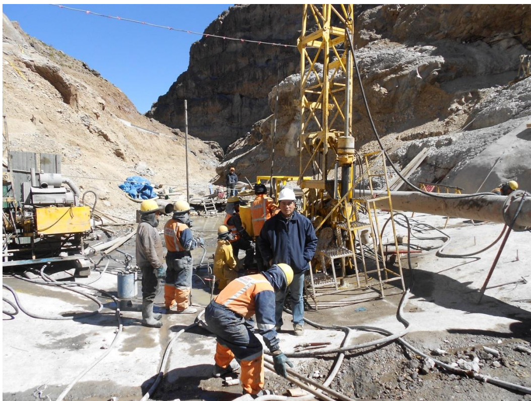
FIGURA N° 41 Inyecciones de lechada de cemento en cauce de presa
