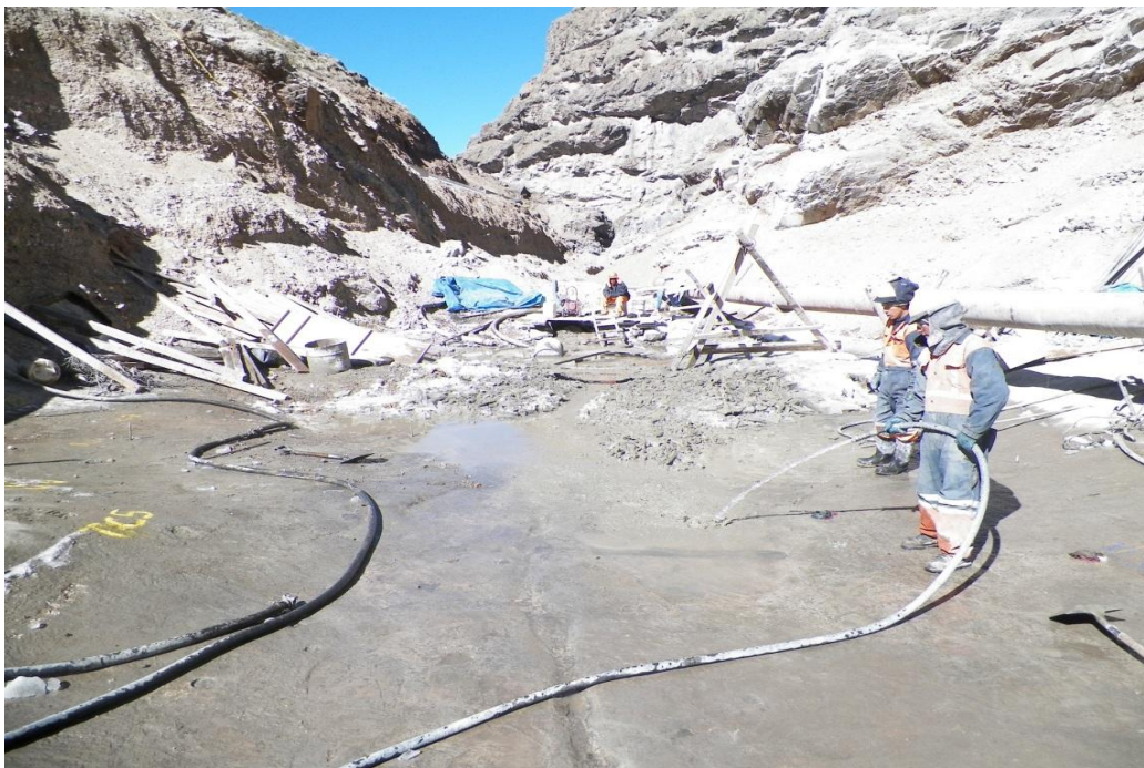
FIGURA N° 40 Lavado de taladros
