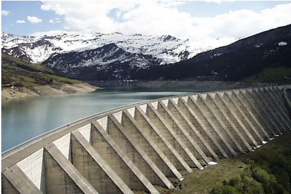
FIGURA N° 10 Presa con contrafuerte
