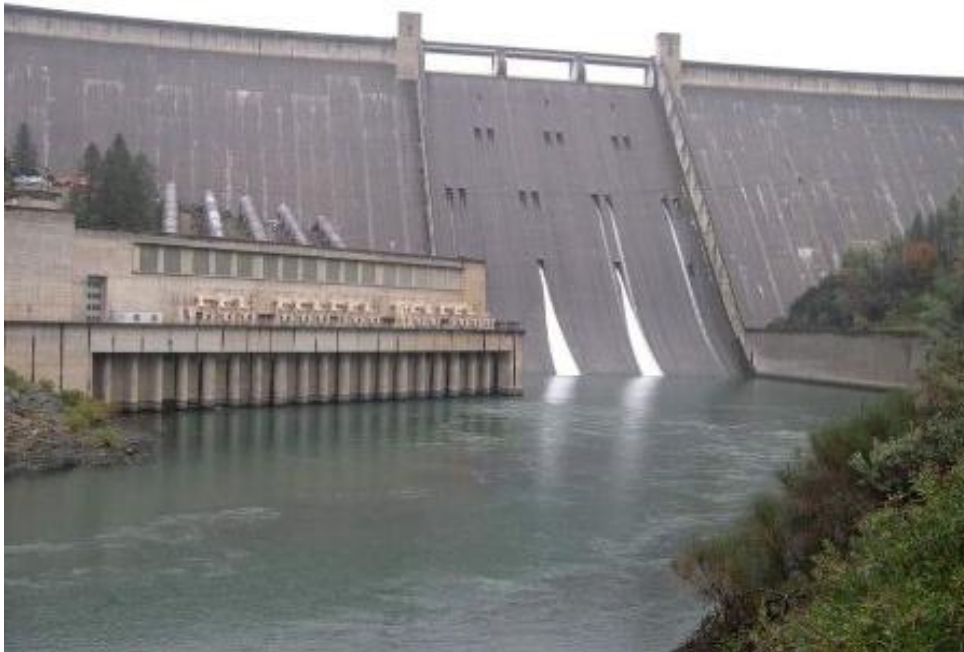
FIGURA N° 08 Presa de gravedad
