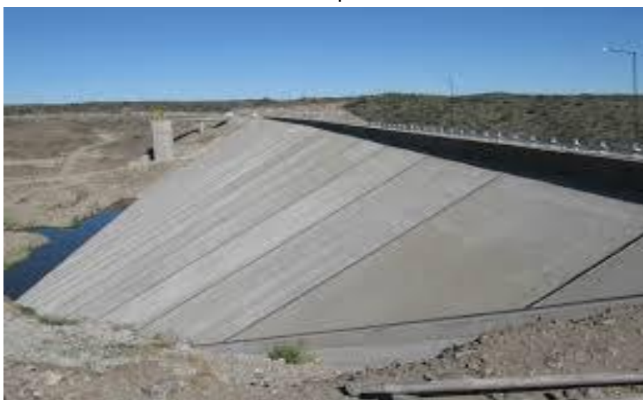
Presas escollera con pantalla de concreto
