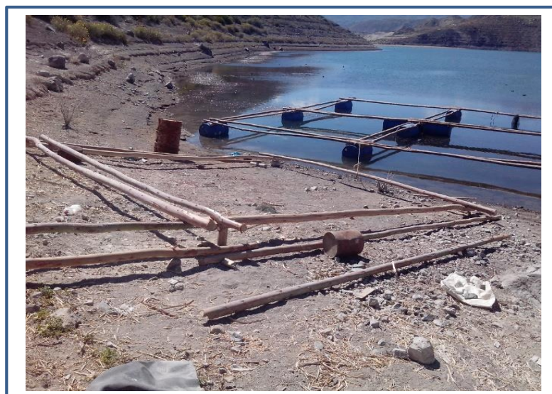
Figura 10: Construcción de las jaulas flotantes. Fuente: Elaboración propia, (2018).
