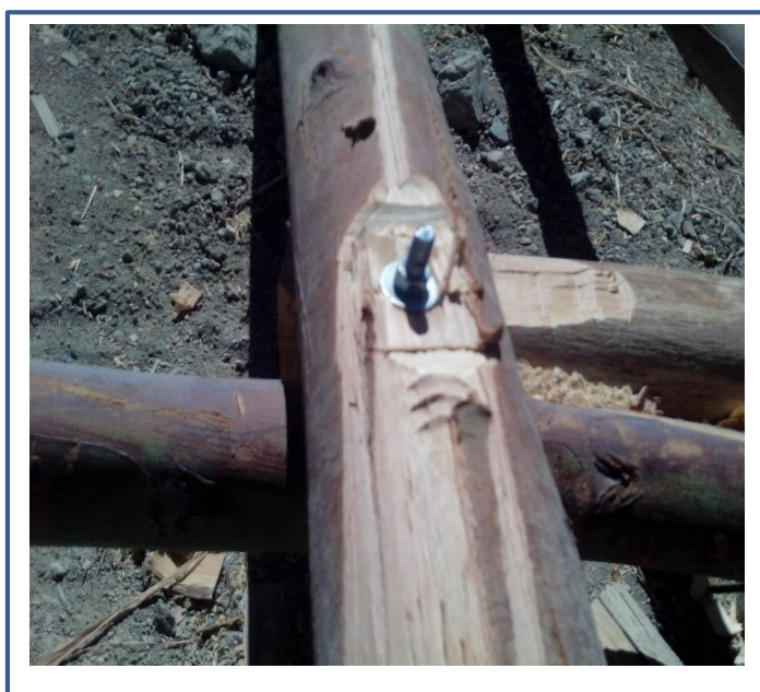
Figura 12: Unión de palos con pernos. Fuente: Elaboración propia, (2018).
