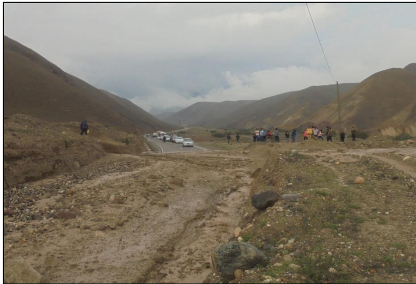
Figura 2.20. Emergencia vial huayco progresiva km 46+500 tramo: Tacna – Tarata.
