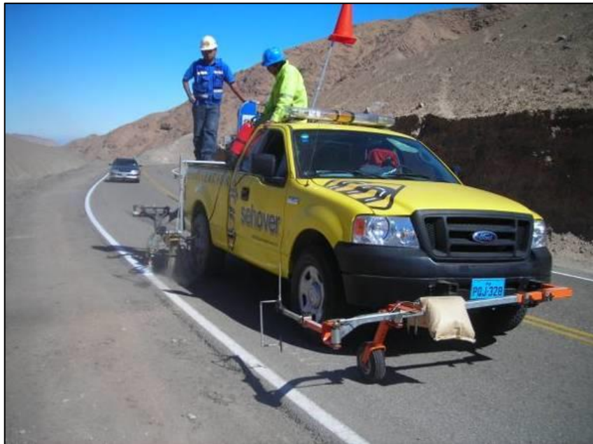
Figura 2.15. Demarcación de pavimento Tacna – Tarata progresiva km 51+450.
