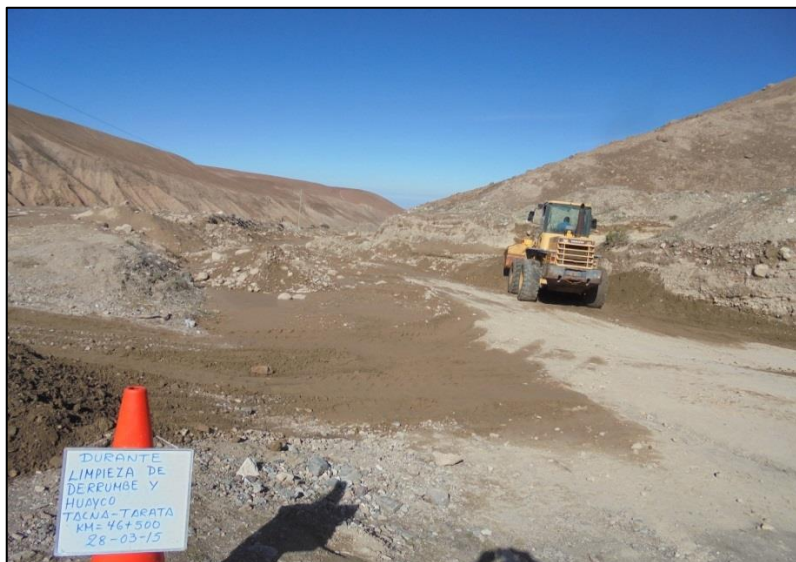
Figura 2.21. Atención a la emergencia vial progresiva km 46+500 tramo: Tacna – Tarata.
