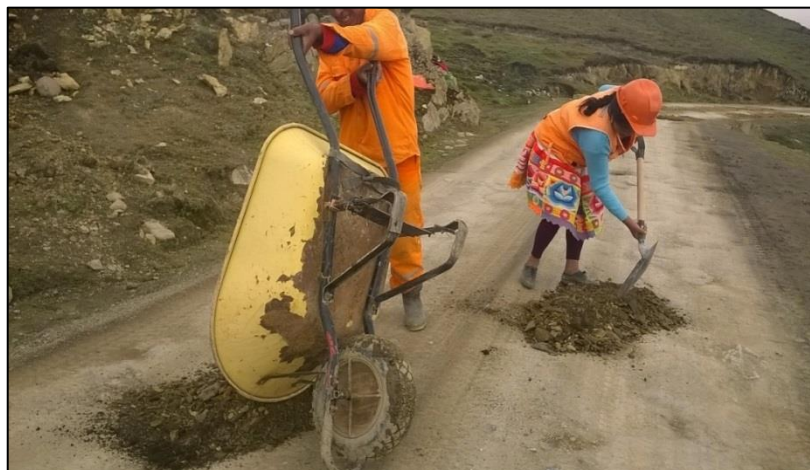
Figura 2.30. Trabajos de bacheo en redes no pavimentadas.
