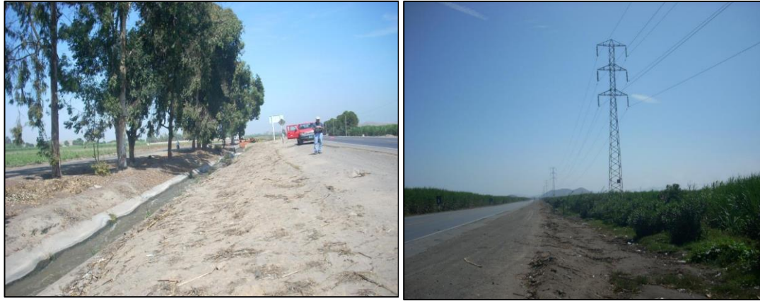
Figura 2.34. Interferencias en concesiones como: canal de regadío y líneas de transmisión.
