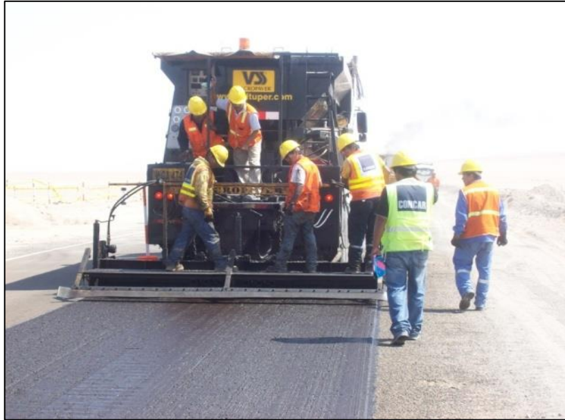
Figura 2.19. Lechada asfáltica Tacna – Tarata progresiva km 20+000.
