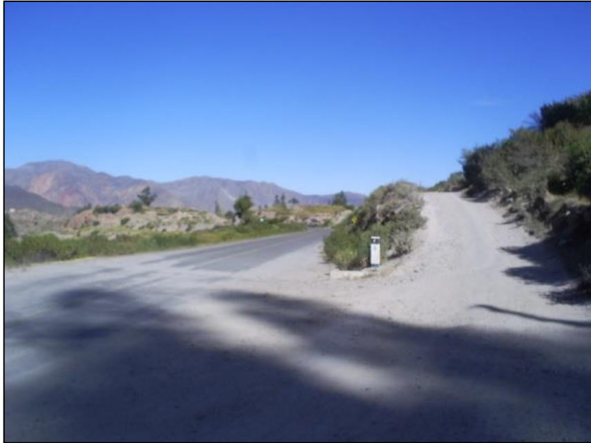
Figura 4.13. Desvió al C.P de Capazo km 89+980 a nivel de sub rasante.
