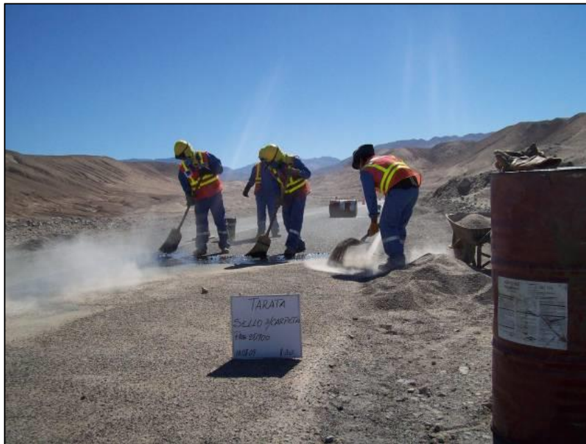
Figura 2.17. Sello de arena Tacna – Tarata progresiva km 20+900. Fuente: Provias Nacional zonal Tacna-Moquegua
