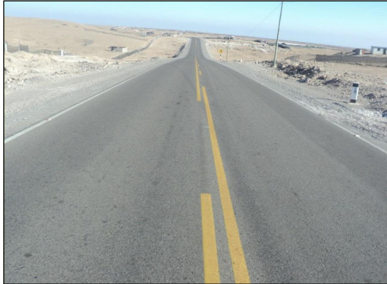
Figura 4.5. Se mantiene la Conservación de vía debidamente señalizada km 15+000.
