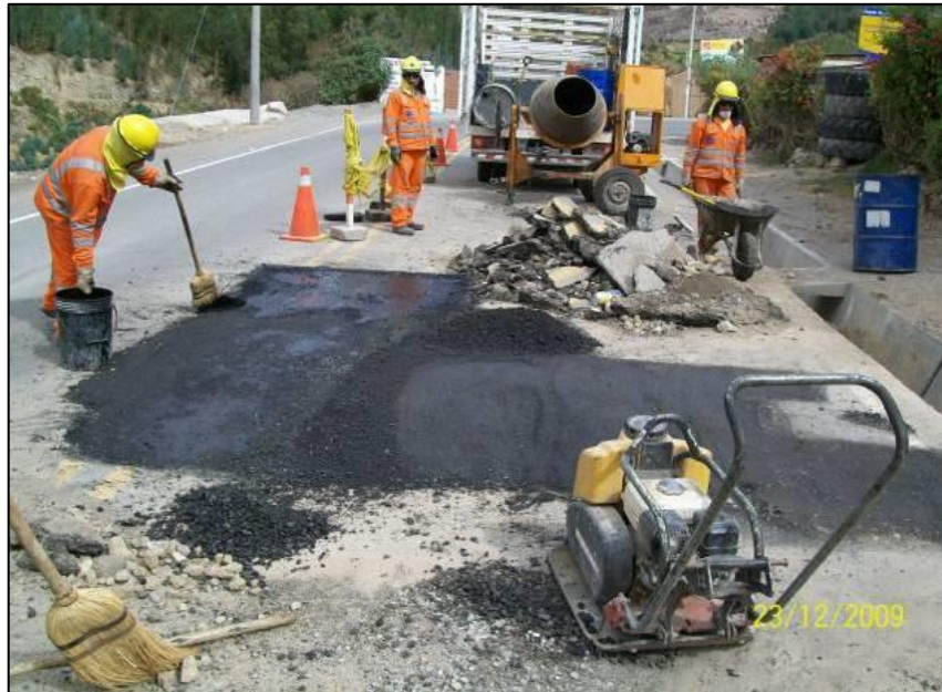
Figura 2.18. Bacheo profundo en calzada Tacna – Tarata progresiva km 73+950.
