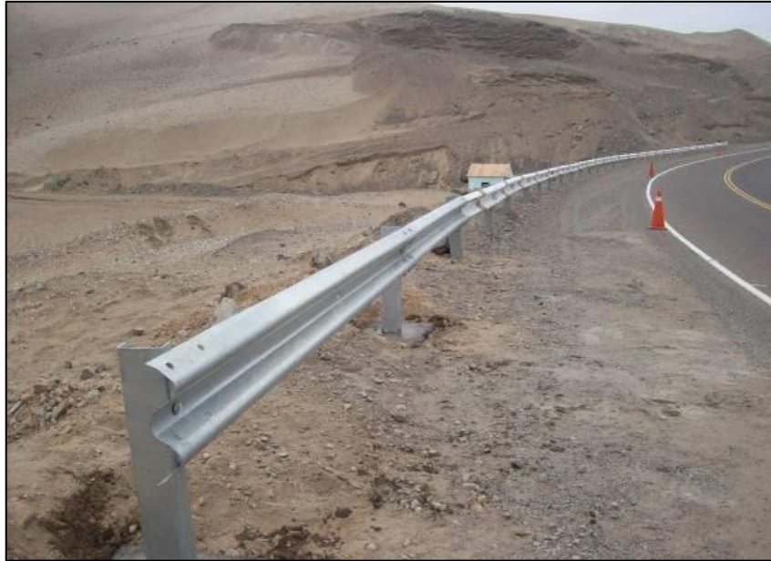
Figura 2.16. Reposición y reparación de guardavía Tacna – Tarata progresiva km 69+200. Fuente: Provias Nacional zonal Tacna-Moquegua
