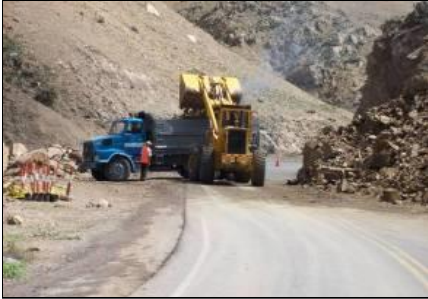
Figura 2.14. Limpieza de derrumbes Tacna –Tarata progresiva km 56+900.
