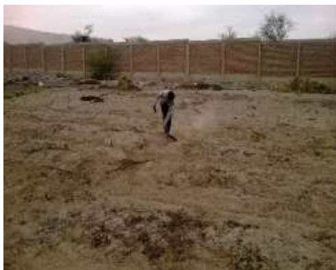
Limpieza del terreno
