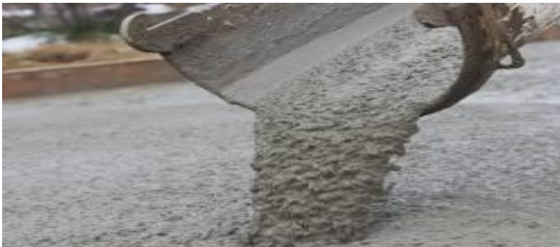
Fraguado de concreto
