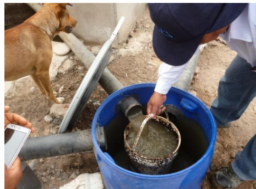
Figura 11. Aforo caudal de ingreso
