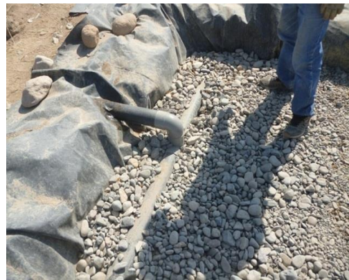
Figura 36: Disposición tuberías conducción
