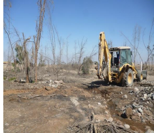
Figura 33: Trabajos de habilitación de zona de reúso
