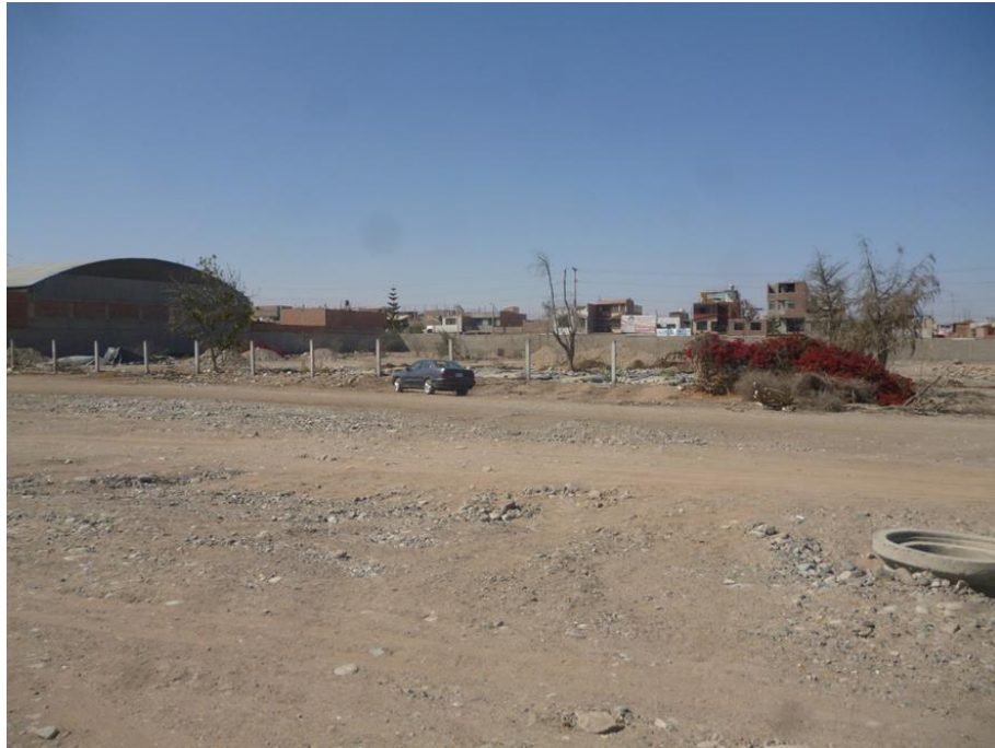
Figura 19. Zona de construcción de los humedales artificiales y lagunas anaerobias
