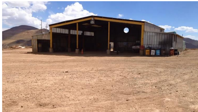
Figura A1 Imagen del taller de mantenimiento
