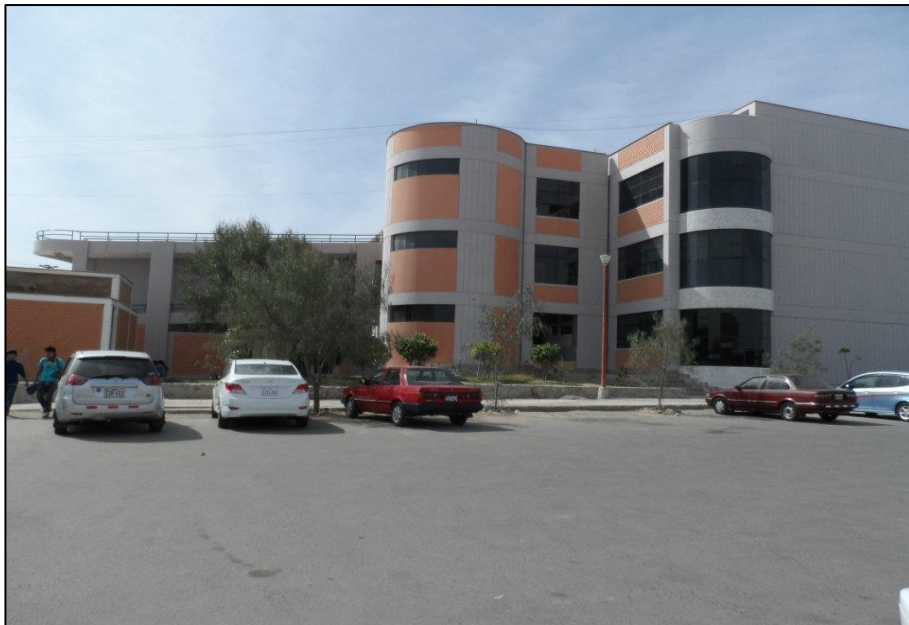
Foto 8. Área de estacionamiento de vehículos de docentes
