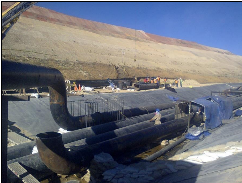
Montaje mecánico de Tuberías
