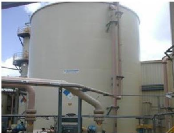
Figura No. 23 Tanque de solución barren
