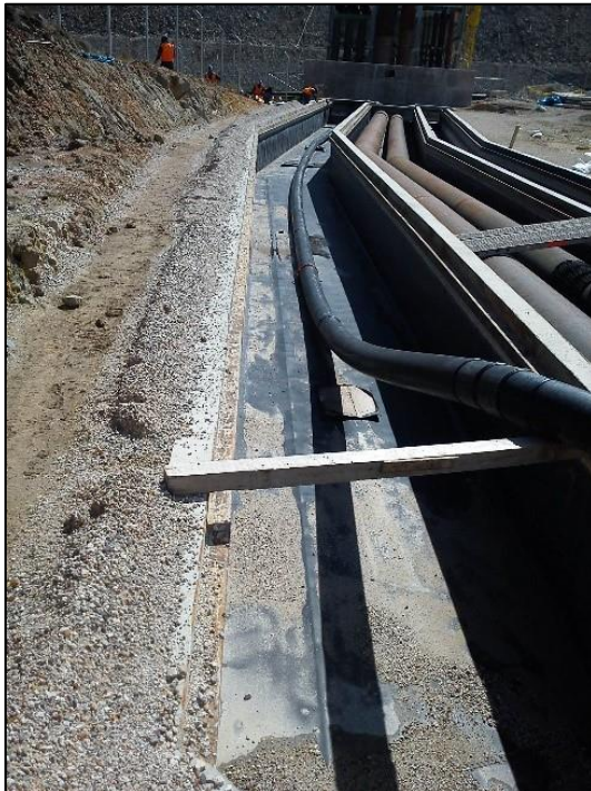
Tubería HDPE
