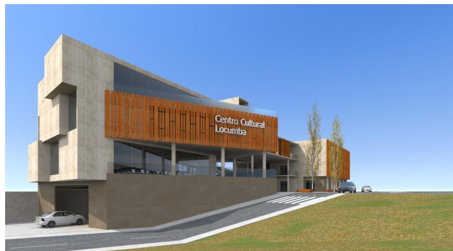
Vista lateral derecho del centro cultural
