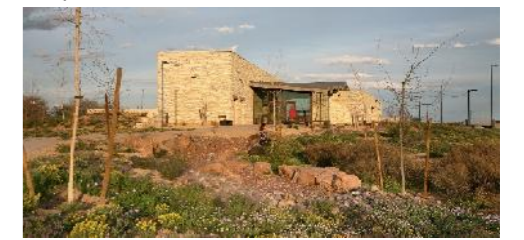
Tratamiento de áreas exteriores
