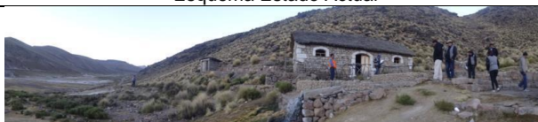
Vista de infraestructura existente
