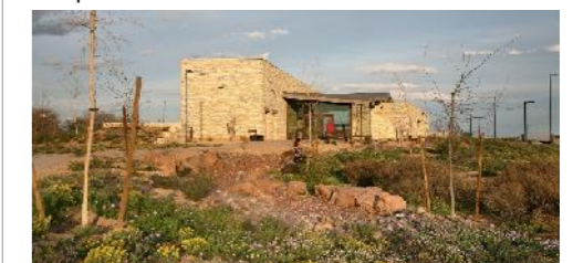
Tratamiento de áreas exteriores
