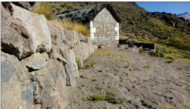
Infraestructura de los baños termales
