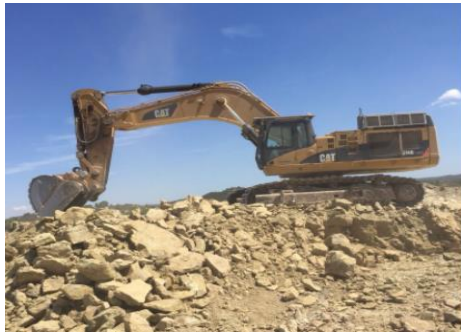
Figura 29. Excavadora 374DL Fuente: Flota de equipos DCR.
