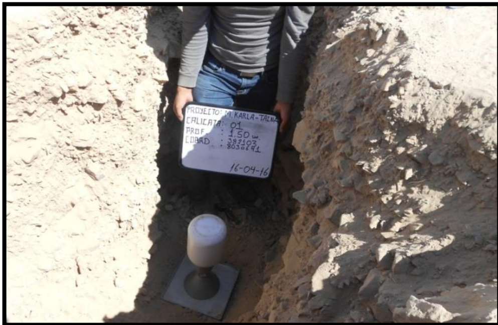
FOTO 04: Ensayo de densidad In situ
