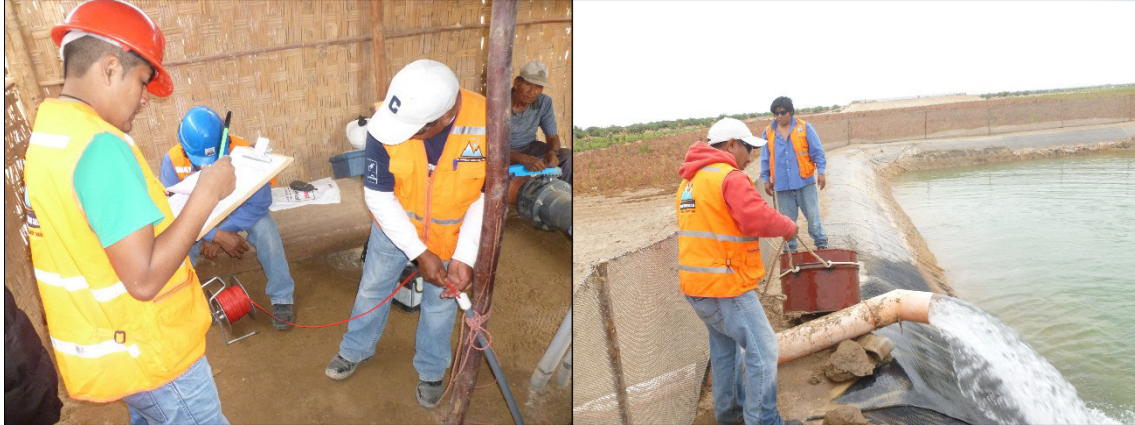
Foto 1 y 2: Medición de niveles de descenso en el pozo IRHS-064 (Coordenadas UTM WGS-84: 347184 Este y 7987009 Norte) y medición de caudales por el método volumétrico, mediante el uso de un cilindro calibrado y un cronómetro.
