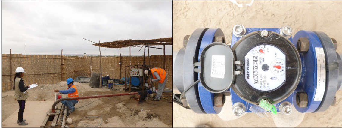
Foto 29 y 30: Medición de niveles de descenso en el pozo Nuevo Horizonte de la Asoc. Vivienda Nuevo Horizonte (Coordenadas UTM WGS-84: 347812 Este y 7991510 Norte) y medición de caudales por caudalímetro, mediante el uso de un cronómetro.
