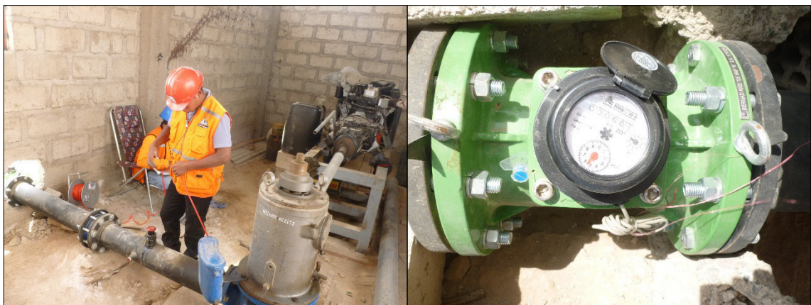
Foto 39 y 40: Medición de niveles de descenso en el pozo N°02 de la Asoc. San Juan (Coordenadas UTM WGS-84: 339114 Este y 7991943 Norte.) y medición de caudales por caudalímetro, mediante el uso de un cronómetro.
