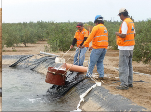
Foto 17 y 18: Medición de niveles de descenso en el pozo La Rosa de la Asoc. Flor de Primavera - Pachacutec (Coordenadas UTM WGS-84: 348775 Este y 7985869 Norte) y medición de caudales por el método volumétrico, mediante el uso de un cilindro calibrado y un cronómetro.
