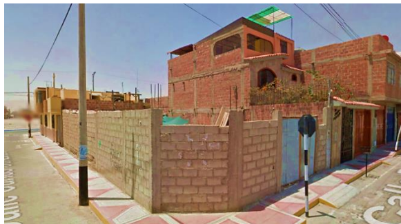
Figura 47. Edificación con material noble
