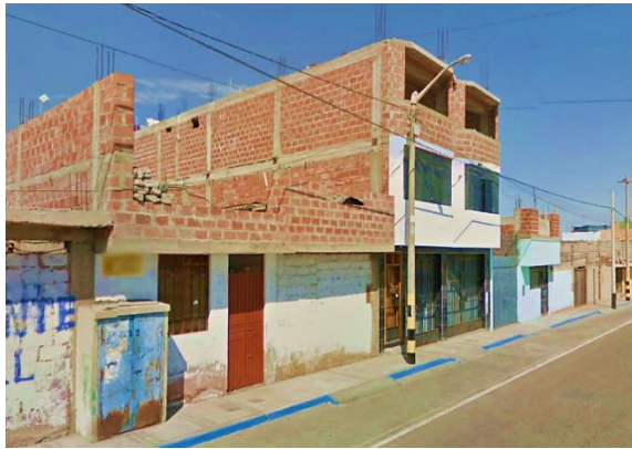
Figura 45. Edificación de albañilería confinada
