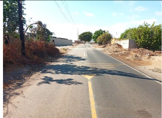
FOTO 48: Km 0+240; reductor de velocidad tipo resalto de sección circular con cuerda de 4 m. al ingreso de Asentamiento Humano Frontera del Sur.
