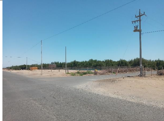
FOTO 22: Km 6+620; presencia de postes de concreto de energía de alta tensión a un metro de distancia de la calzada.
