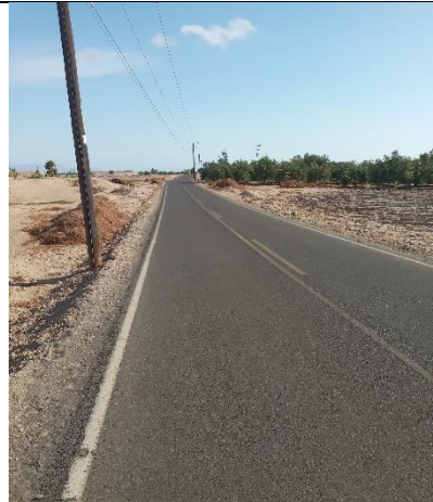
FOTO 24: Km 4+090 y Km 3+990; presencia de postes de madera con energía de alta tensión a 40 cm de distancia de la calzada.
