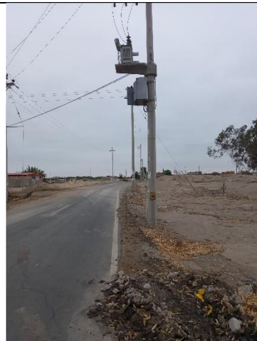
FOTO 24: Km 4+090 y Km 3+990; presencia de postes de madera con energía de alta tensión a 40 cm de distancia de la calzada.
