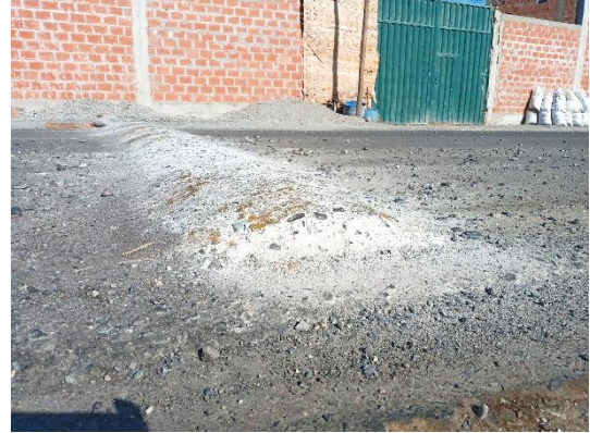
FOTO 46: Km 2+920; reductor de velocidad tipo resalto de sección circular con cuerda de 4 m. al ingreso de Asentamiento Humano Frontera del Sur.
