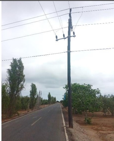
FOTO 23: Km 4+680; presencia de poste de madera con energía de alta tensión a 20 cm de distancia de la calzada.
