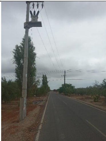
FOTO 23: Km 4+680; presencia de poste de madera con energía de alta tensión a 20 cm de distancia de la calzada.
