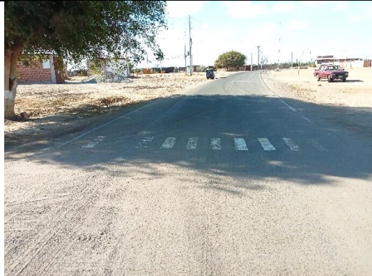
FOTO 47: Km 2+870; señal de proximidad a reductor de velocidad tipo resalto.
