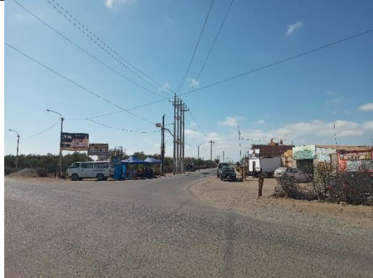
FOTO 21: Km 4+710; presencia de postes de concreto de energía de alta tensión con transformador a un metro de distancia de la calzada.
