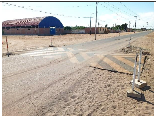
FOTO 48: Km 0+240; reductor de velocidad tipo resalto de sección circular con cuerda de 4 m. al ingreso de Asentamiento Humano Frontera del Sur.
