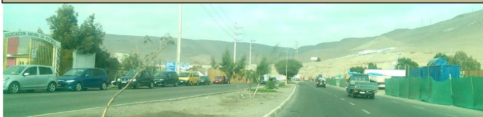
IMAGEN N° 04 Estado de Conservación
