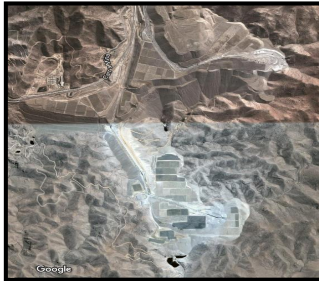
Figura 10. Sección de lixiviación. Fuente: Google Earth.
