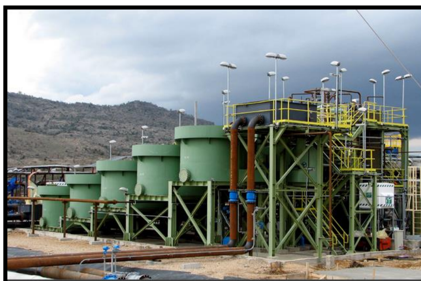
Figura 17. Planta ADR de mina Pucamarca Fuente: Comunicación personal, 2013.
